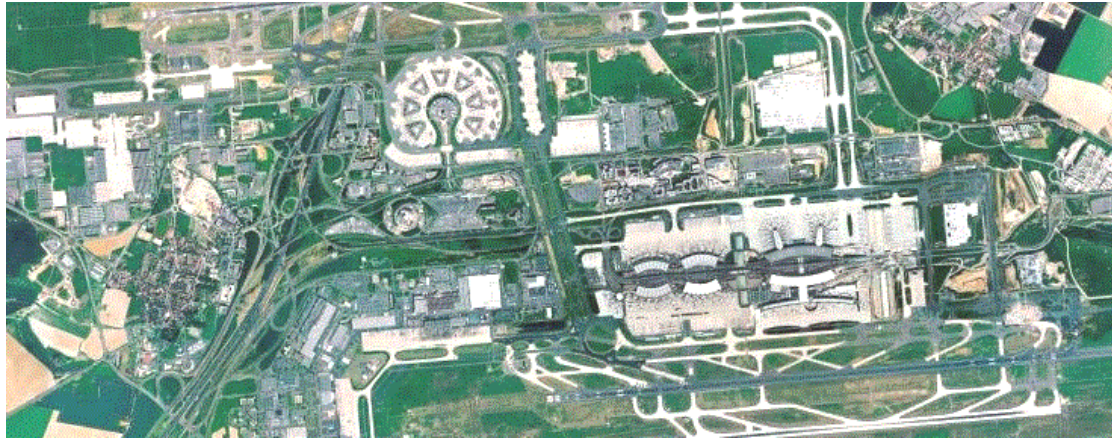
Σχήμα 2.11 Περιοχή προσομοίωσης στο αεροδρόμιο CharlesdeGaulle ( https://www.aimsun.com/wp/wp-content/uploads/2015/02/cdg-airport-aimsun.jpg )
