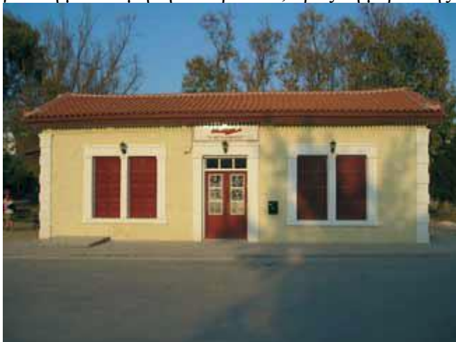
Εικ.81.Ο σταθμός του Αττικού Σιδηροδρόμου. (Πηγή: Μ.Μαρμάνη –Φ. Μαρμάνη, Περιήγηση στην πόλη, φωτογραφία Ν. Χαλιωτής).
