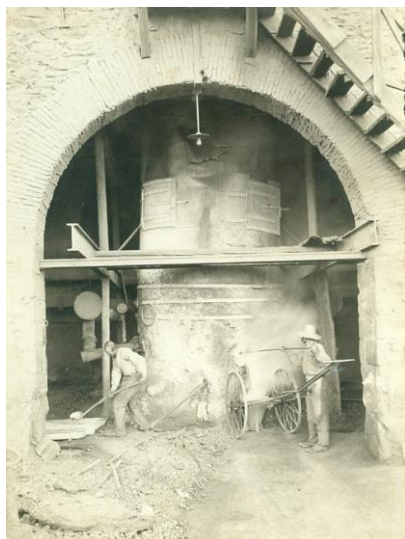
Εικ9. Φωτογραφία καμίνου, τύπου Castellano. (Πηγή: από το αρχείο του τέως Δημάρχου Λαυρεωτικής, κ. Σταύρου Παπασταυρόπουλου).
