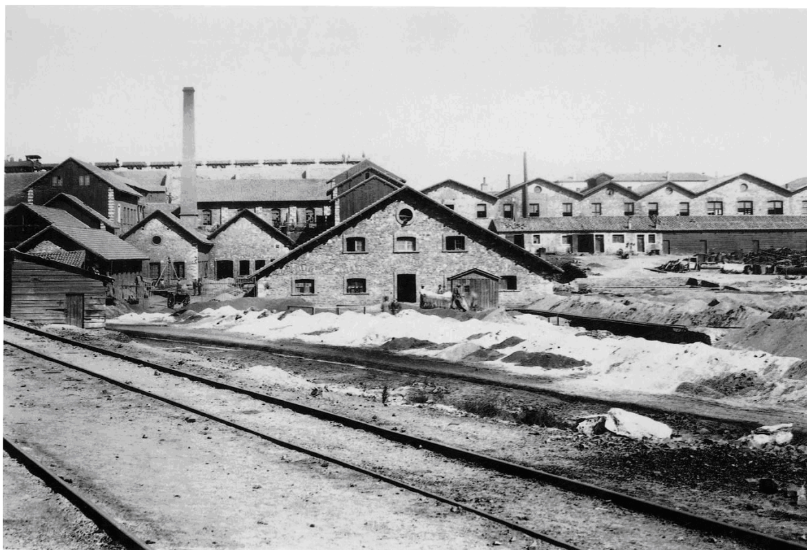
Εικ. 10. Οι εγκαταστάσεις εμπλουτισμού μεταλλευμάτων (Flotation) της ΓΕΜΑ στον Κυπριανό, στο Λαύριο.
