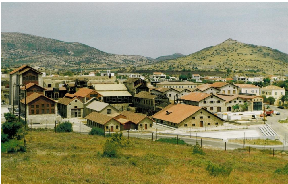
Εικ.1 Το συγκρότημα της πρώην ΓΕΜΑ, σημερινό Τεχνολογικό Πολιτιστικό Πάρκο Λαυρίου (ΤΠΠΑ).
