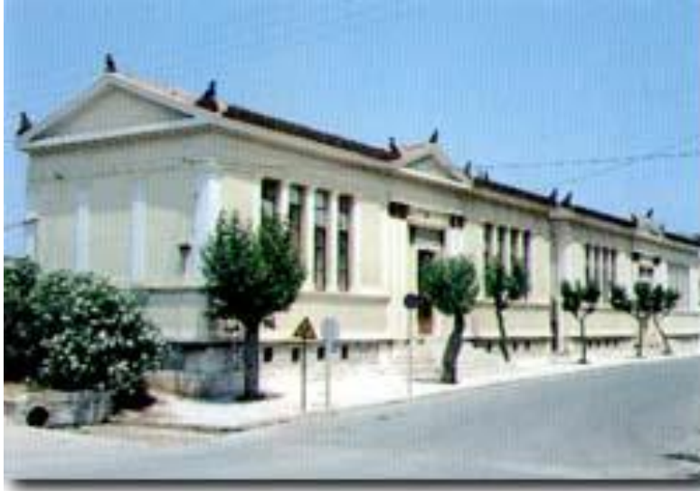
Εικ.46. Άλλη όψη του Α' Δημοτικού Σχολείου Λαυρίου.
