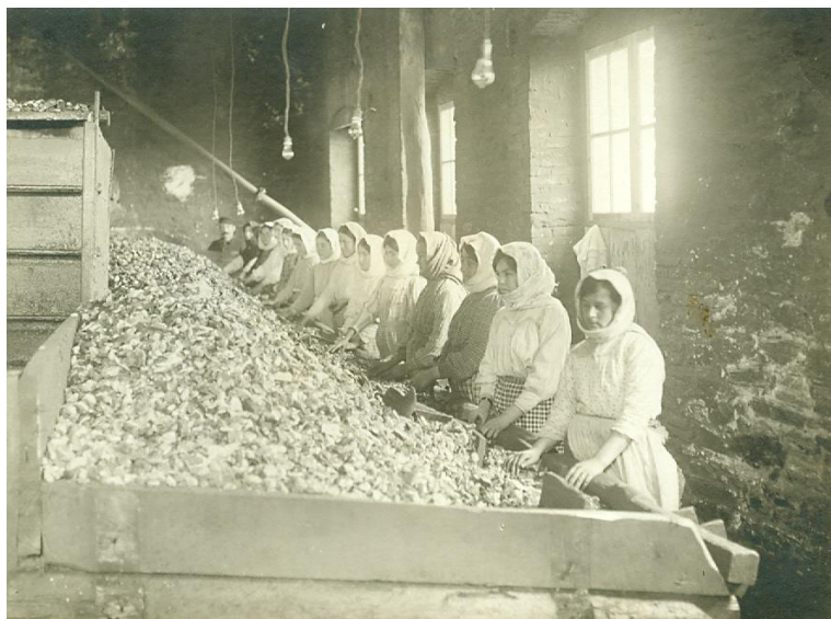
Εικ.41. Χειροδιαλογή μεταλλευμάτων στο μεταλλοπλύσιο (πλυντήριο) της ΓΕΜΑ, κατά την εποχή λειτουργίας της.(Πηγή: από το αρχείο του τέως Δημάρχου Λαυρεωτικής, κ. Σταύρου Παπασταυρόπουλου).
