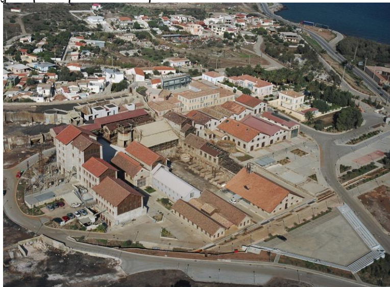
Εικ. 89. Αποψη από ψηλά του συγκροτήματος της ΓΕΜΑ, σημερινού ΤΠΠΑ. (Πηγή : από το αρχείο του κ. Δ. Δράκου).
