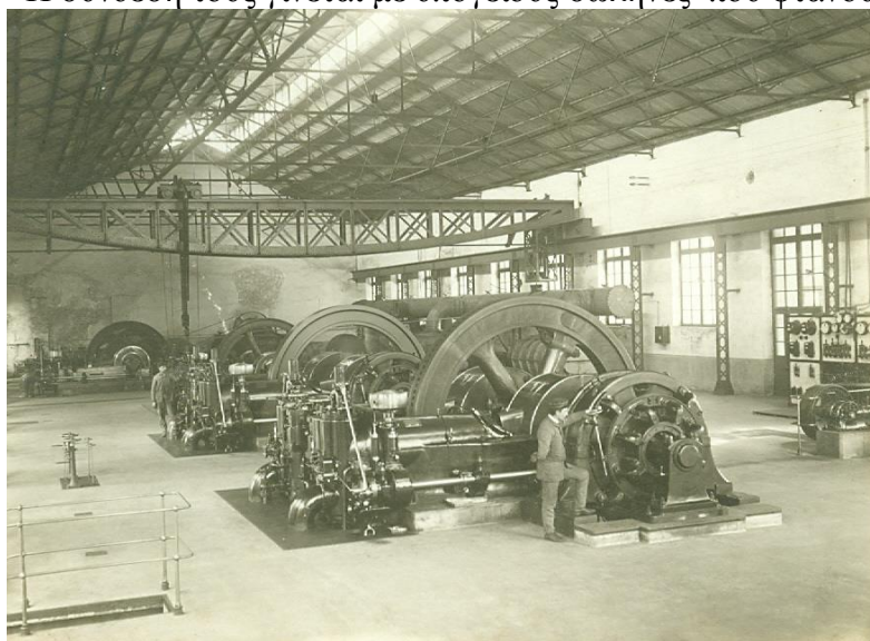
Εικ.47. Μονάδα παραγωγής ηλεκτρισμού (γκαζομηχανή) την εποχή λειτουργίας της ΓΕΜΑ. (Πηγή: από το αρχείο του τέως Δημάρχου Λαυρεωτικής, κ. Σταύρου Παπασταυρόπουλου).
