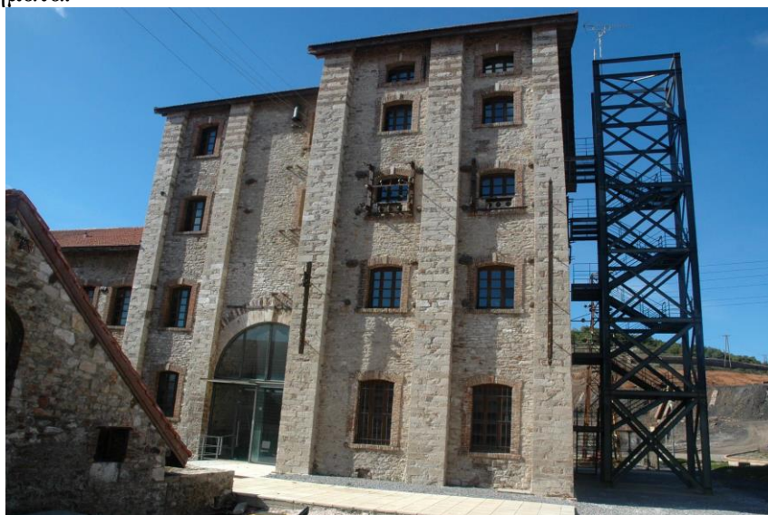
Εικ.44. Ανατολική άποψη της σημερινής εικόνας του κτηρίου του Ξυλουργείου με τη σιδηροκατασκευή κλιμακοστασίου κινδύνου και την ανατολική είσοδο.(Πηγή : από το αρχείο του ΤΠΠΛ).
