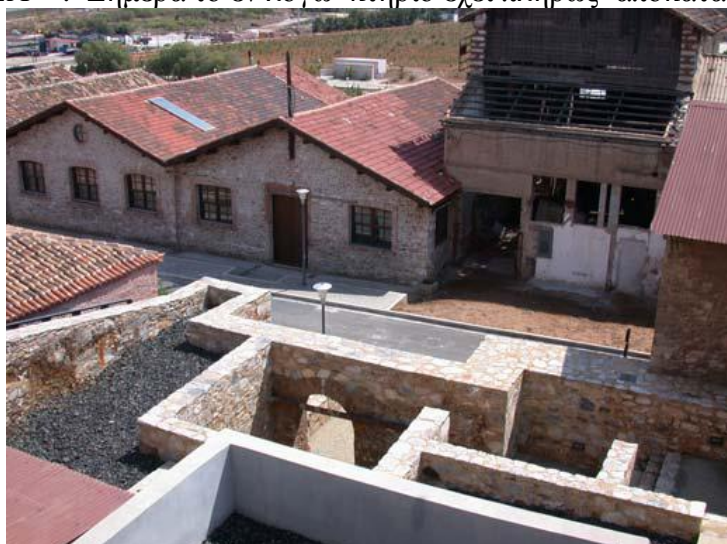
Εικ.28. Το Μηχανουργείο το2003 στην άνω πλευρά.
