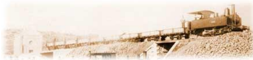
Εικ.32. Ο σιδηρόδρομος μεταφοράς των σκουριών. (Πηγή : από το site : lavrio@eranel.gr ).
