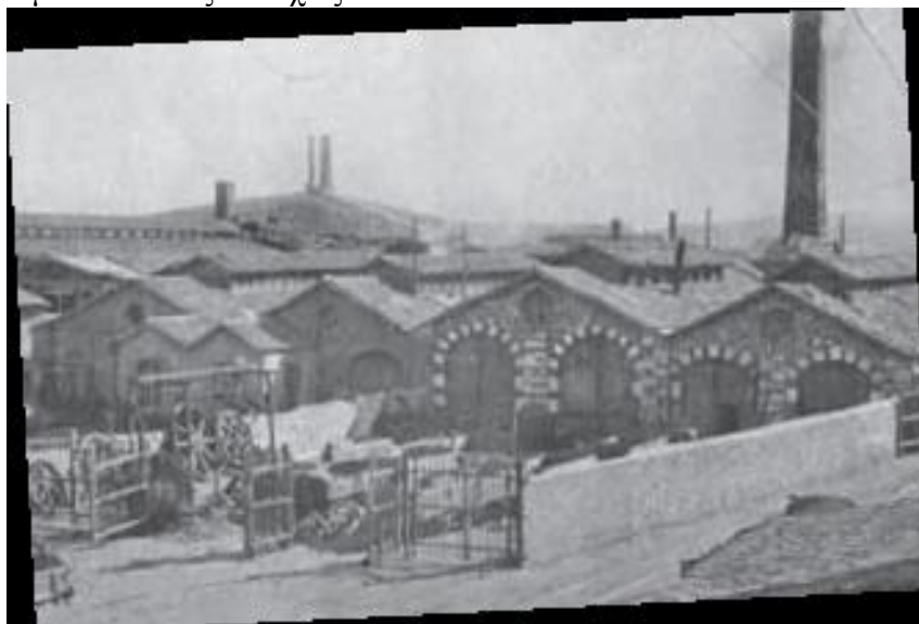
Εικ.17. Το Συγκρότημα του Μηχανουργείου. Η χρονολογική αποτύπωση της συγκεκριμένης εικόνας υπολογίζεται στο έτος 1912. (Πηγή : Η φωτογραφία προέρχεται από το ενημερωτικό έντυπο «Societe des Usines de Laurium» του 1912, από το αρχείο του Εμποριοεπαγγελματικού Συλλόγου Λαυρίου «Ο Ερμής»).
