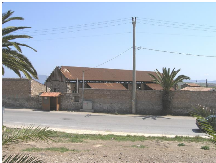
Εικ.90. Άποψη των Αποθηκών της Γαλλικής Εταιρείας Μεταλλείων Λαυρίου. (Πηγή : από το αρχείο του κ. Δ. Δράκου).
