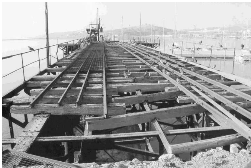
Εικ. 14: Οι Σιδηροτροχιές της Γαλλικής Σκάλας.
