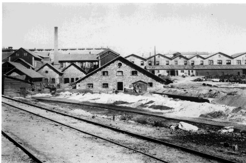
Ε. Εγκαταστάσεις εμπλουτισμού μεταλλευμάτων (Flotation) της C.F.M.L. στον Κυπριανό.
