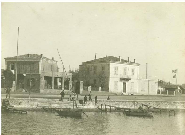
Εικ.75. Το κτήριο του Τελωνείου - Οικία Ιωάννη Βαπτιστή Σερπιέρη- Ανδρέα Κορδέλλα -παλιότερα ΙΚΑ Λαυρίου-σήμερα ιδιόκτητο κτήριο. (Πηγή : Σ. Πασταυροπουλος τ. Δήμαρχος Λαυρεωτικής).
