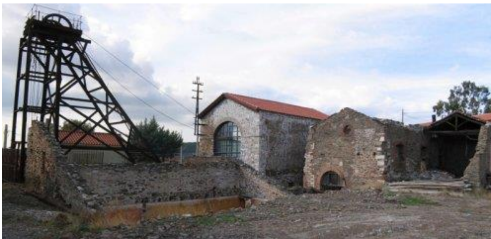
Εικ. 39. Σημερινή εικόνα του μεταλλικού ανέλκυστήρα και των εγκαταστάσεων του Φρέατος Σερπιέρη. (Πηγή : Α. Παπάς, site monumenta, Βιομηχανικά Κατάλοιπα).
