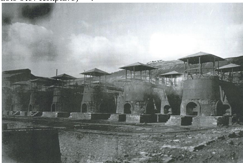
Εικ.8. Φούρνοι καλαμίνας στην περιοχή του Κυπριανού, οι οποίες δεν υφίστανται σήμερα. (Πηγή : από το αρχείο του Μ.Μαρκουλή -ΙΑΕΜ).
