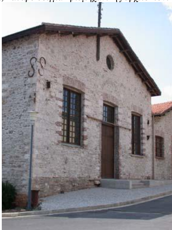
Εικ.26. Το Μηχανουργείο το 2003 στην άνω πλευρά.
