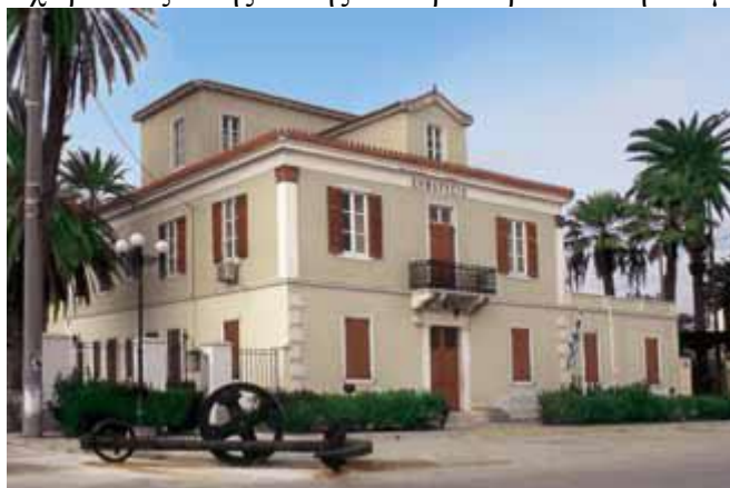
Εικ. 65. Το Διοικητήριο της Εταιρείας Μεταλλουργείων Λαυρίου- Το πρώτο κτήριο του Νεότερου Λαυρίου-Σημερινό Δημαρχείο. Πηγή : Μ. Μαρμάνη –Φ. Μαρμάνη, Περιήγηση στην πόλη, φωτογραφία Ν. Χαλιορής).
