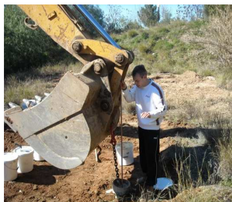
Εικόνα 3.8: Διάνοιξη ορυγμάτων με εκσκαφέα βαρέως τύπου.
