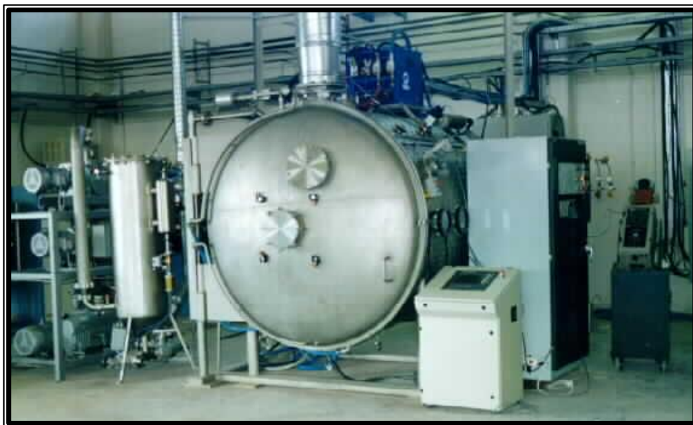
Εικόνα 5.6. Εγκατάσταση θαλάμου θερμικών ψεκασμών πλάσματος υπό κενό.
