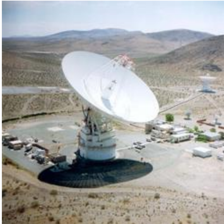
Εικόνα 3.1 Η κεραία διαμέτρου 70m στο Goldstone της California, με φόντο την έρημο Mojave. Στα δεξιά διακρίνεται η κεραία υψηλής απόδοσης με διάμετρο 34m[58]
