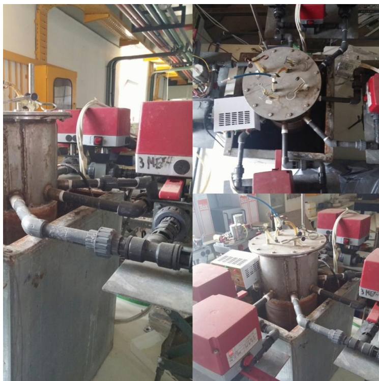
Εικόνα 7.2 Εγκατάσταση σταθερών σωληνώσεων στον αντιδραστήρα PABR
