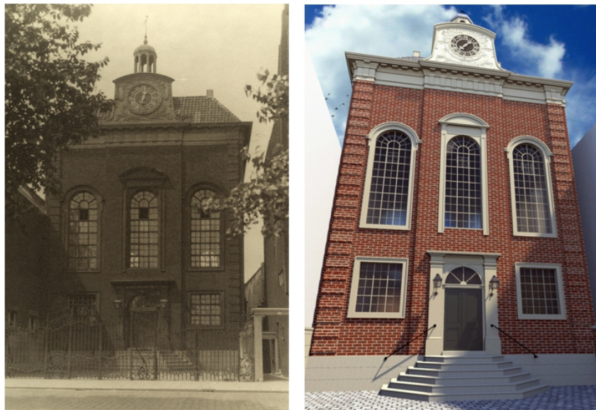
Σχήμα 2.23: Δημιουργία μοντέλου BIM της κατεστραμμένης συναγωγής του Rotterdam βάσει σχεδίων και φωτογραφιών (De Paere , 2013).
