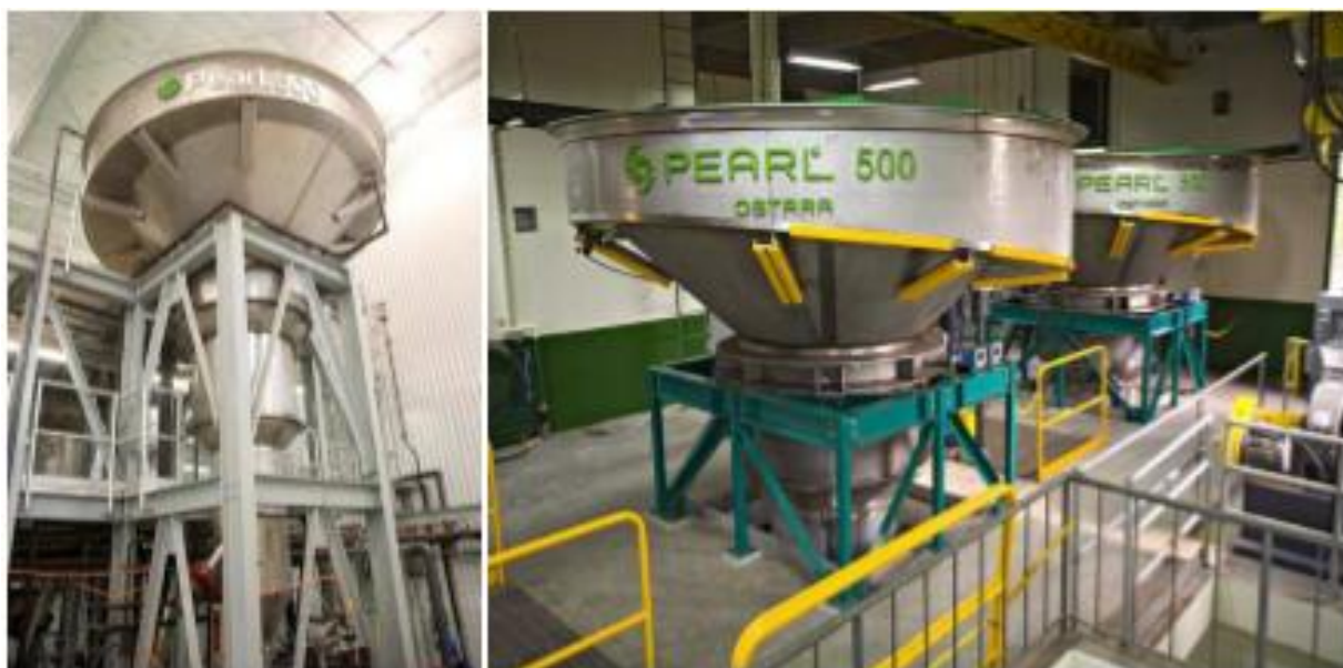
Σχήμα 4.2: Αντιδραστήρας Ostara ,τεχνολογίας Pearl®
