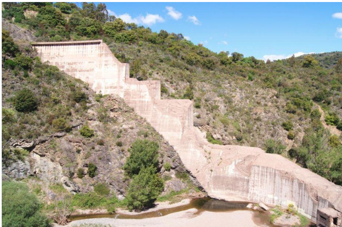
Εικόνα 1.5 : Το φράγμα Malpasset στη νότια Γαλλία που καταστράφηκε το Δεκέμβριο του 1959 και προκάλεσε το θάνατο 423 ανθρώπων (Πηγή : miles-around.de [7])
