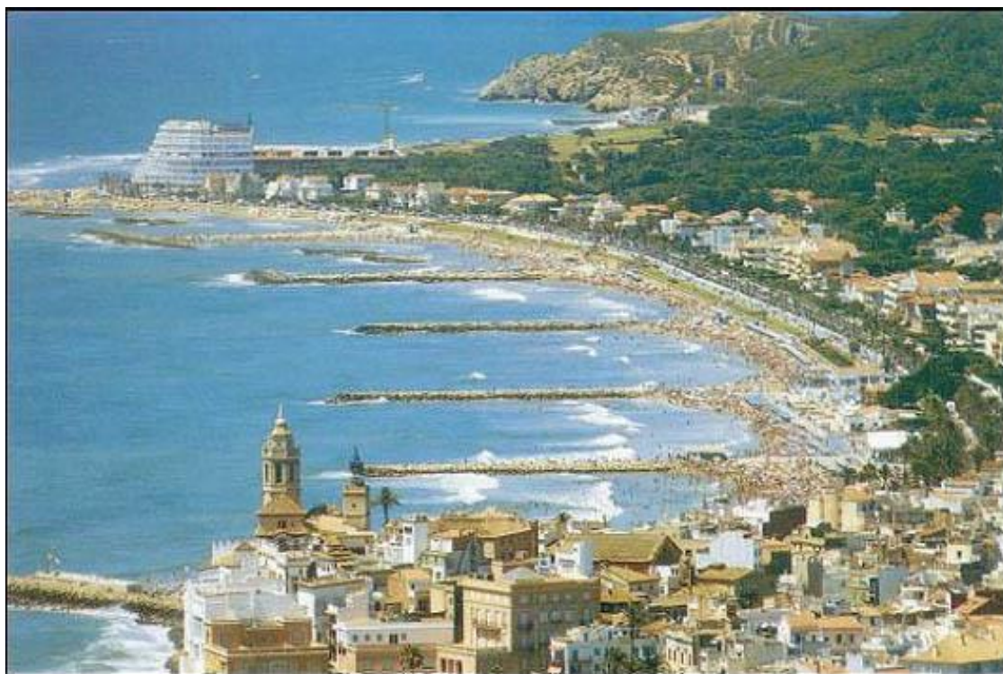
Εικόνα 1.6 : Κατασκευή προβόλων για απόθεση ιζημάτων κατά μήκος της ακτής
