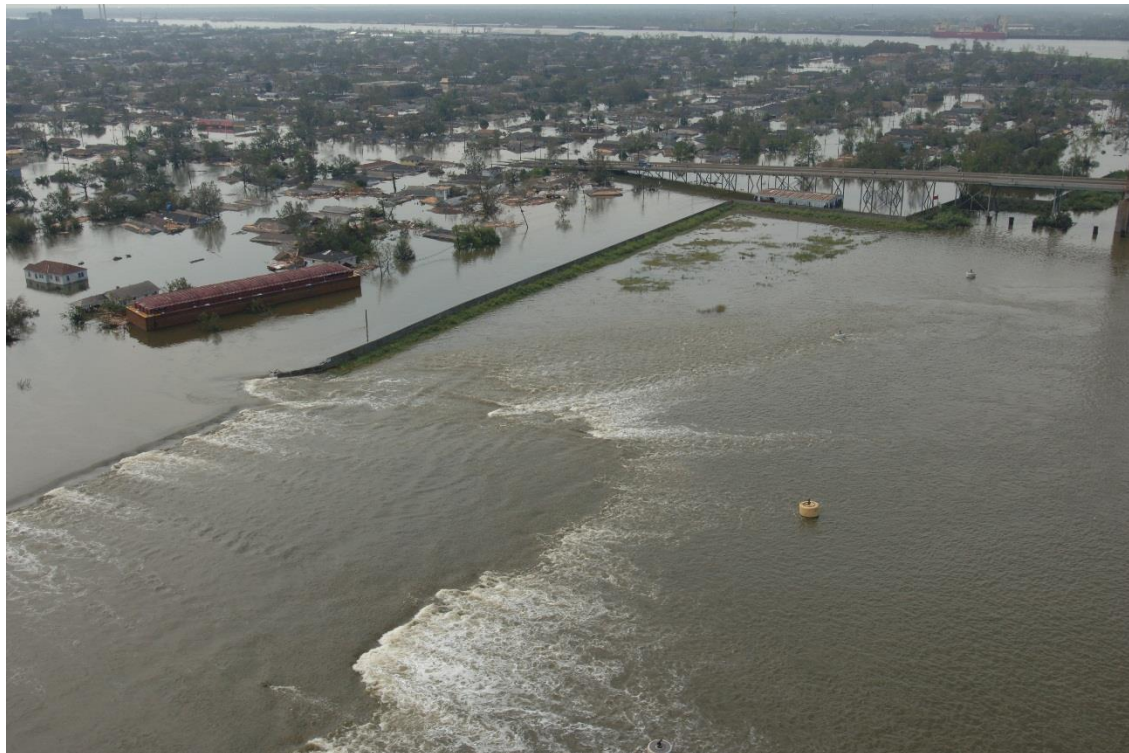
Εικόνα 1.2 : Αστοχία αναχώματος στην Νέα Ορλεάνη (New Orleans) που προκλήθηκε από κύματα του τυφώνα Κατρίνα (Πηγή : commons.wikimedia.org [4])
