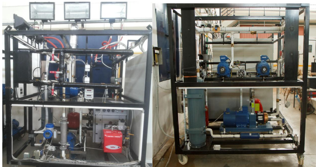
Εικόνα 3.1.4.1: Πειραματική εγκατάσταση ανάκτησης θερμότητας από ζεστά νερά πλοίων που υλοποιήθηκε στο Εργαστήριο Ατμοκινητήρων και Λεβήτων του ΕΜΠ.
