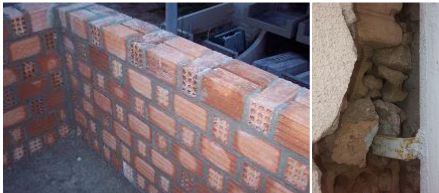
Εικόνα 5.22: α) Παράδειγμα μπατικής τοιχοποιίας, β) Φωτογραφία από την εξωτερική τοιχοποιία του κτηρίου «Οίκος αδελφών», δεύτερος όροφος
