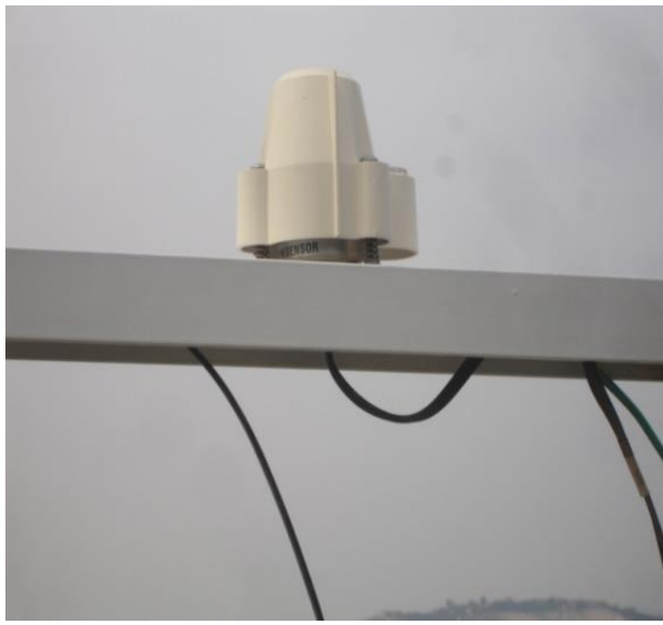
Σχήμα 2.5: Αισθητήρας ηλιακής ακτινοβολίας εγκατεστημένος στο κτίριο ΑΝΥΜ,ΕΜΠ
