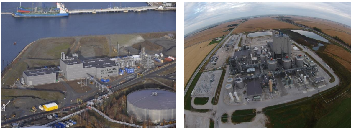
Σχήμα 6: Τα εργοστάσια παραγωγής βιοαιθανόλης δεύτερης γενιάς στο Kalundborg της εταιρείας Inbicon (αριστερά) και στη Nevada της εταιρείας DuPont (δεξιά) (Inbicon, Dupont)
