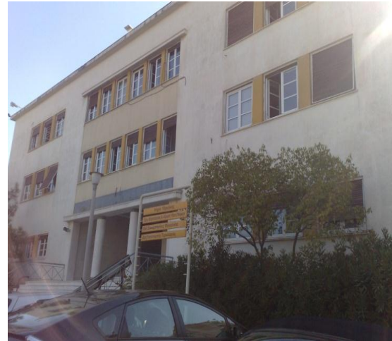
Εικόνα 5.3: Βορειοδυτική όψη κτιρίου.
