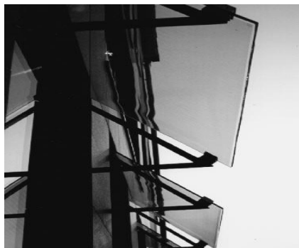
Εικόνα 4.7: Εξωτερική θέα του κατακόρυφου κατευθυντηρίου υαλοπίνακα. Πηγή: Daylight in buildings A source book on daylighting systems and components.
