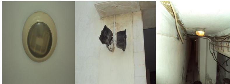
Εικόνα 5.7: Χρήση απαρχαιωμένων φωτιστικών.
