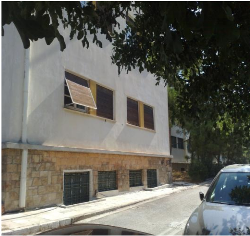
Εικόνα 5.2: Νοτιοδυτική όψη κτιρίου.
