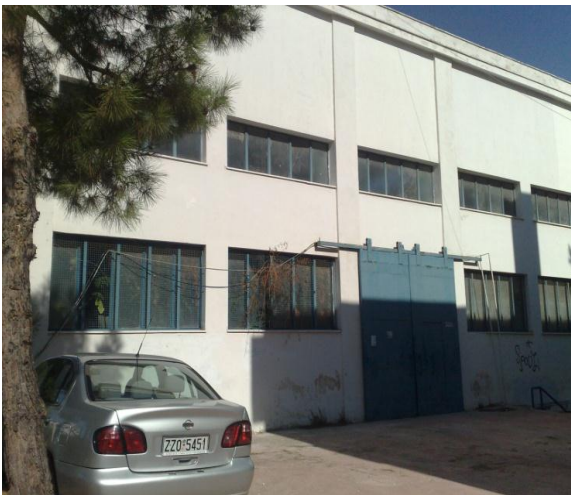
Εικόνα 5.4: Νοτιοανατολική όψη κτιρίου.
