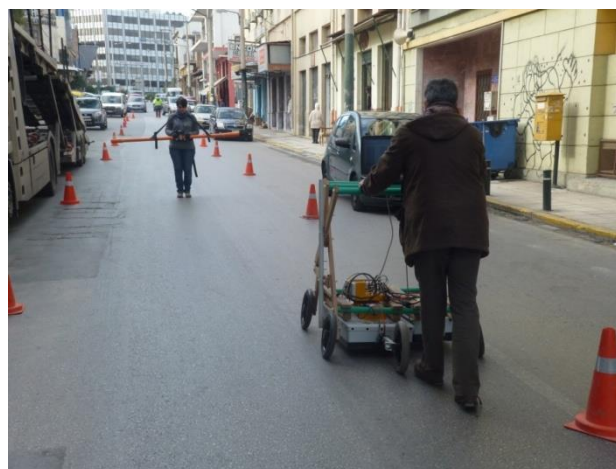
Εικόνα 5.14 Μετρήσεις GPR επί της οδού Ομηρίδου Σκυλίτση
