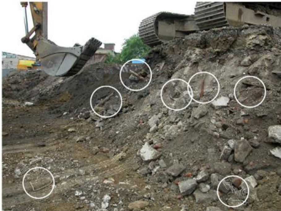
Εικόνα 3.15 Περιεχόμενα πλήρωσης παρατηρούμε υλικά όπως τούβλα θεμέλια από σπλισμένο σκυρόδεμα και μεταλλικές ράβδους και σωλήνες (Boudreault , 2010)
