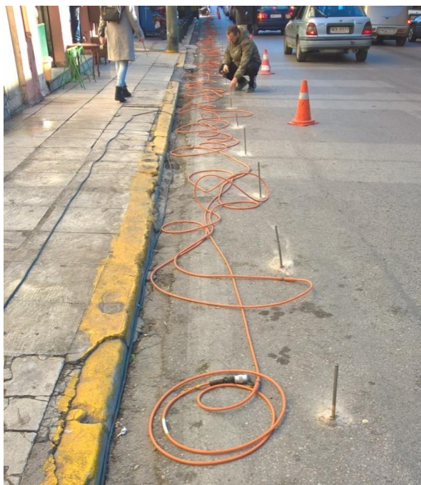
Εικόνα 5.9 Τοποθέτηση ηλεκτροδίων ηλεκτρικής μεθόδου
