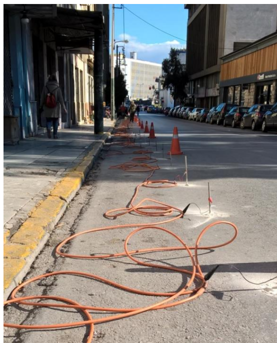
Εικόνα 5.11 Μετρήσεις ηλεκτρικής μεθόδου στην οδό Ομηρίδου Σκυλίτση
