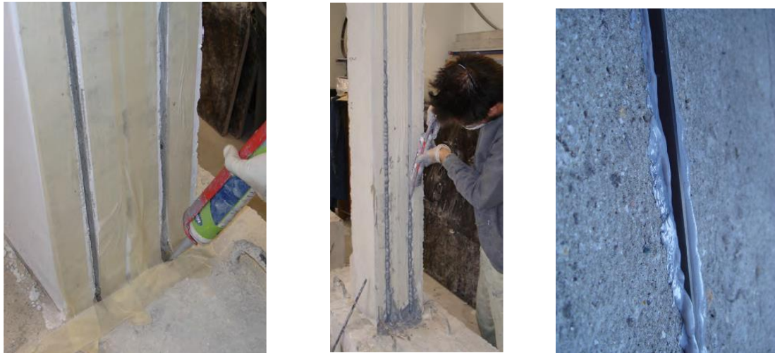
Σχήμα 10.39 Διαδικασία εφαρμογής NSM
