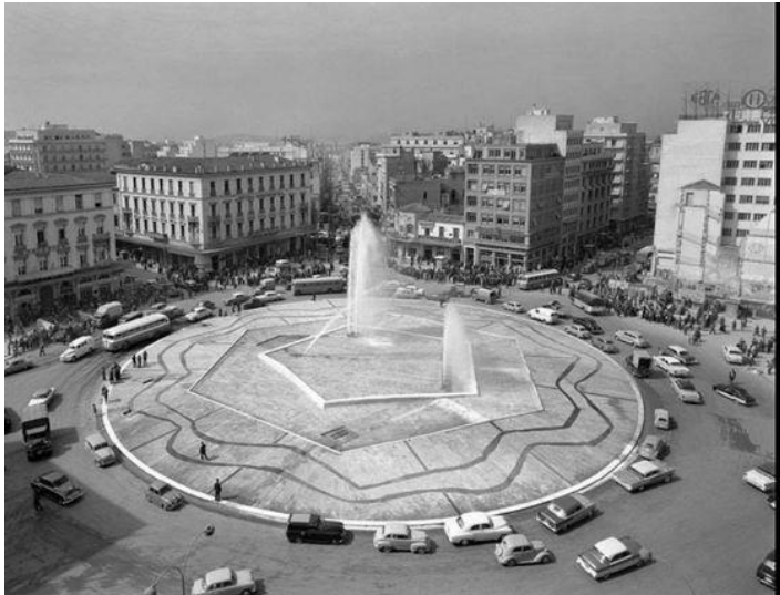
Εικόνα 1.3: Η πλατεία Ομονοίας, στο κέντρο της Αθήνας, το 1959
