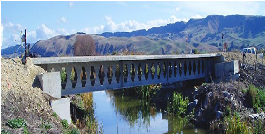
Σχήμα 1-18: Αμφιέριστη γέφυρα με σύμμικτο κατάστρωμα και κύριες δοκούς με διάκενα κορμού
