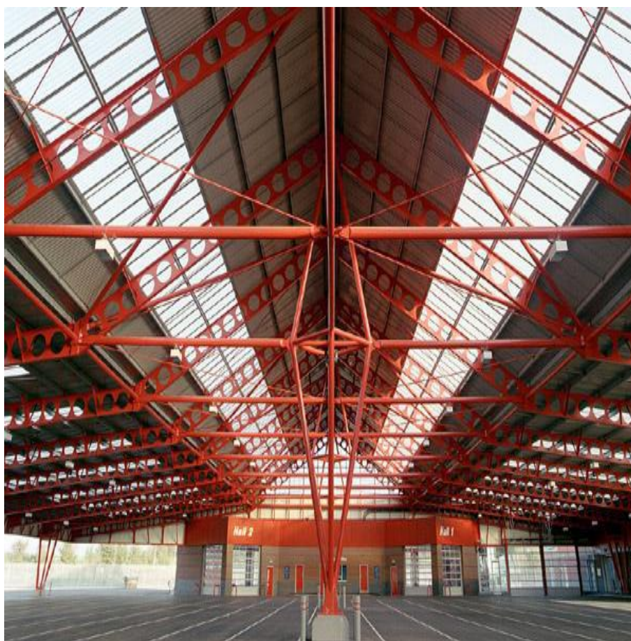
Σχήμα 1-15: Στεγασμένος χώρος parking στη Μεγάλη Βρετανία
