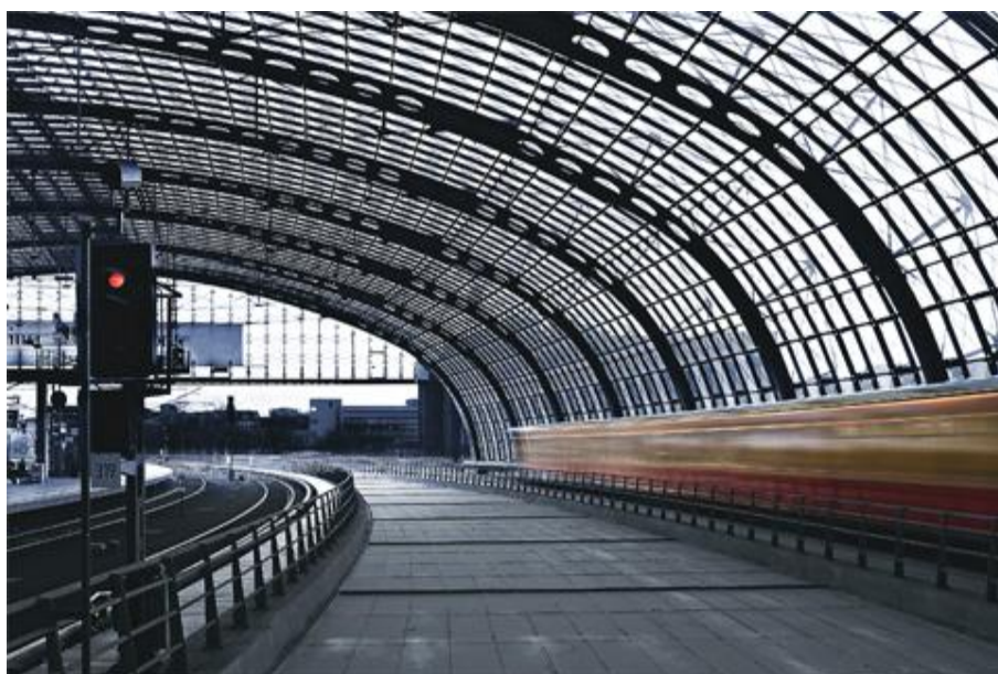
Σχήμα 1-12: Καμπυλωμένες δοκοί με επιμήκη κυκλικά διάκενα κορμού σε σιδηροδρομικό σταθμό στο Βερολίνο
