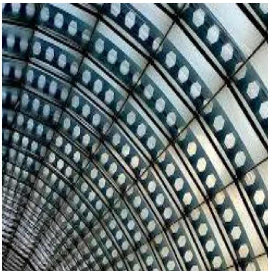
Σχήμα 1-22: Εσωτερικός χώρος κτιρίου με δοκούς διάκενα κορμού
