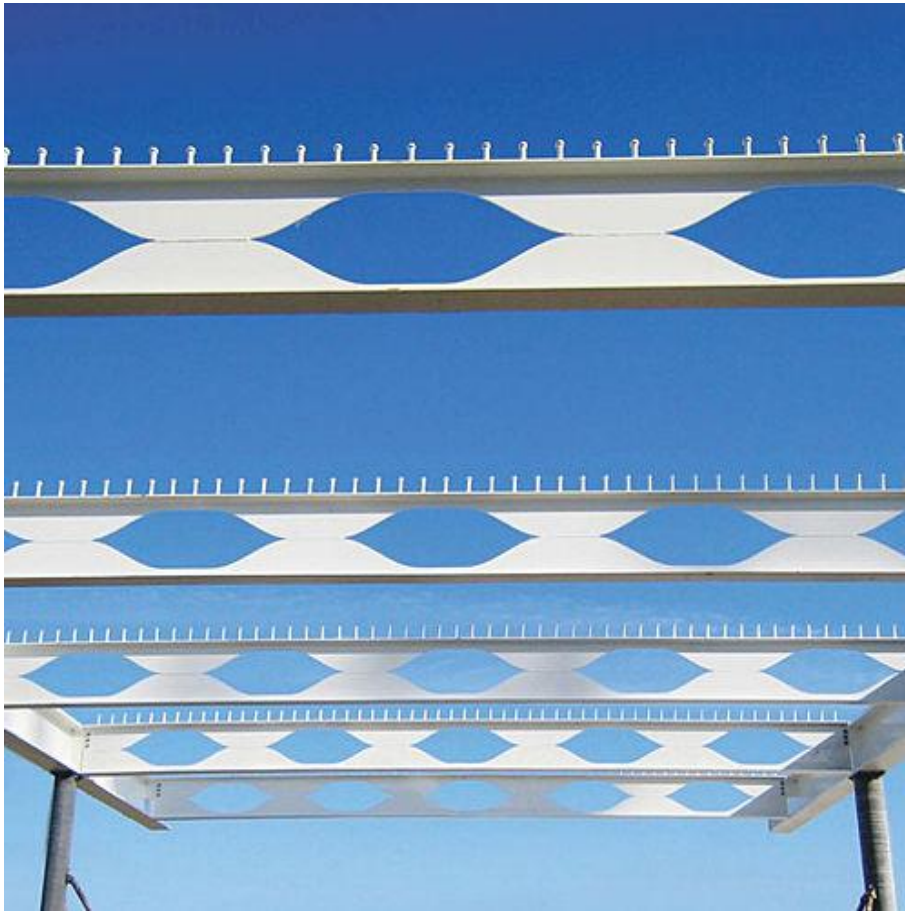
Σχήμα 1-5: Δοκός με επιμήκη διάκενα κορμού
