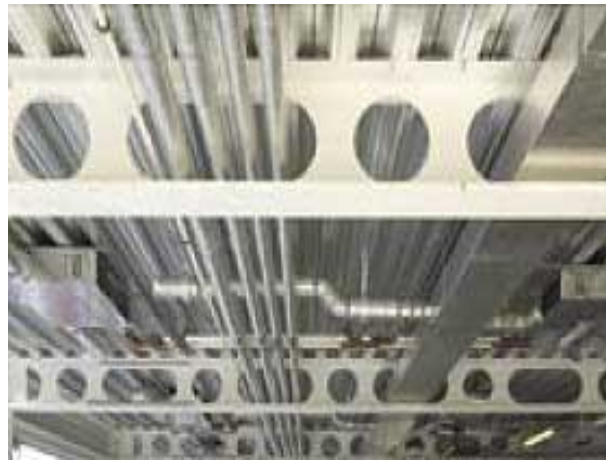
Σχήμα 1-14: Διέλευση πολλών αγωγών διαμέσου επιμηκών διακένων ελλειπτικής μορφής
