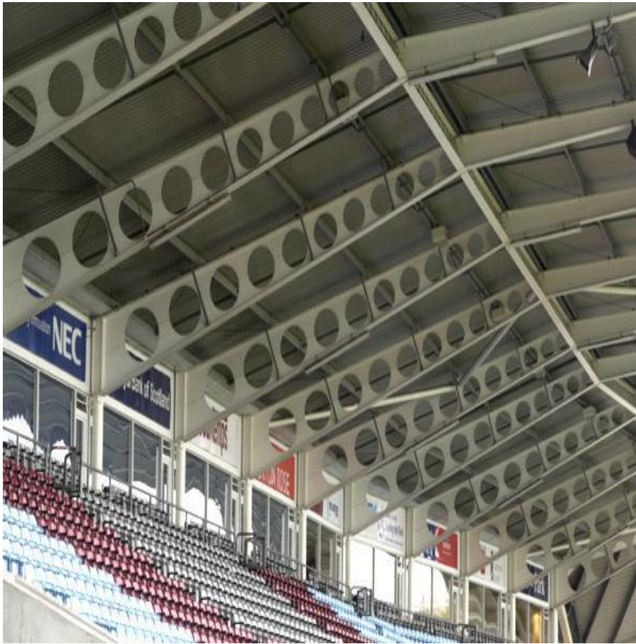
Σχήμα 1-8: Δοκοί με κυκλικά διάκενα κορμού μεταβαλλόμενου ύψους, ανοίγματος 12 m σε γήπεδο του Λονδίνου
