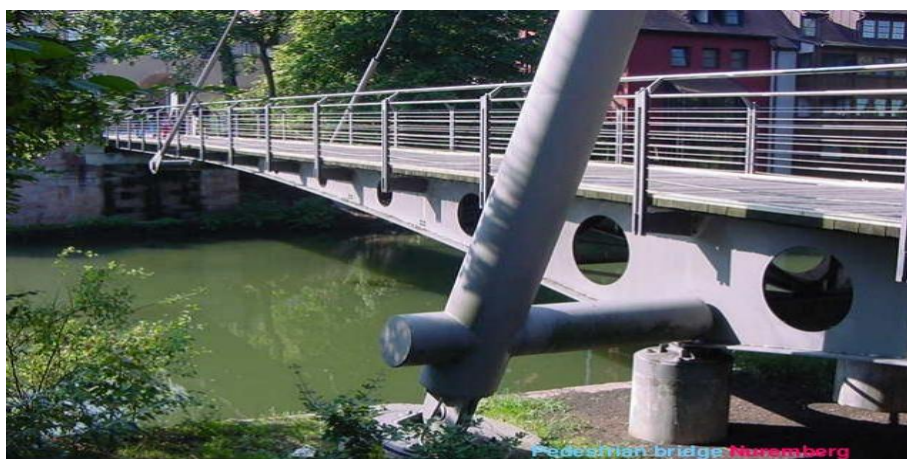
Σχήμα 1-19: Γέφυρα με κύριες δοκούς με κυκλικά διάκενα κορμού μεταβαλλόμενου ύψους
