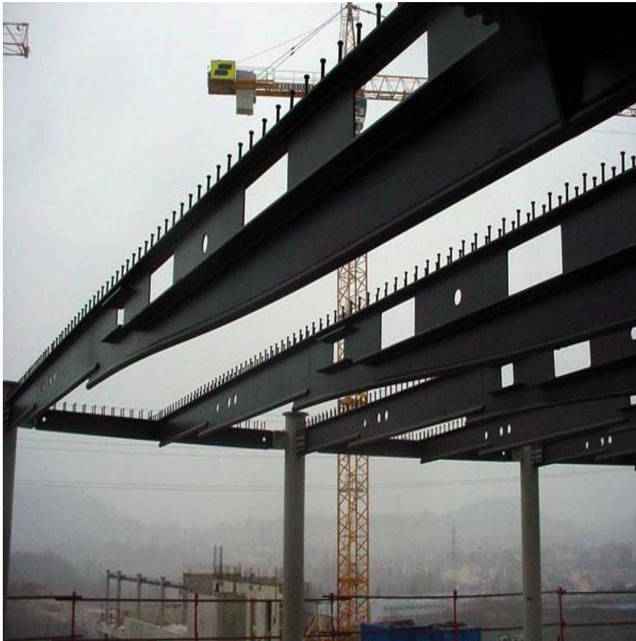
Σχήμα 1-2: Litzka Beam
