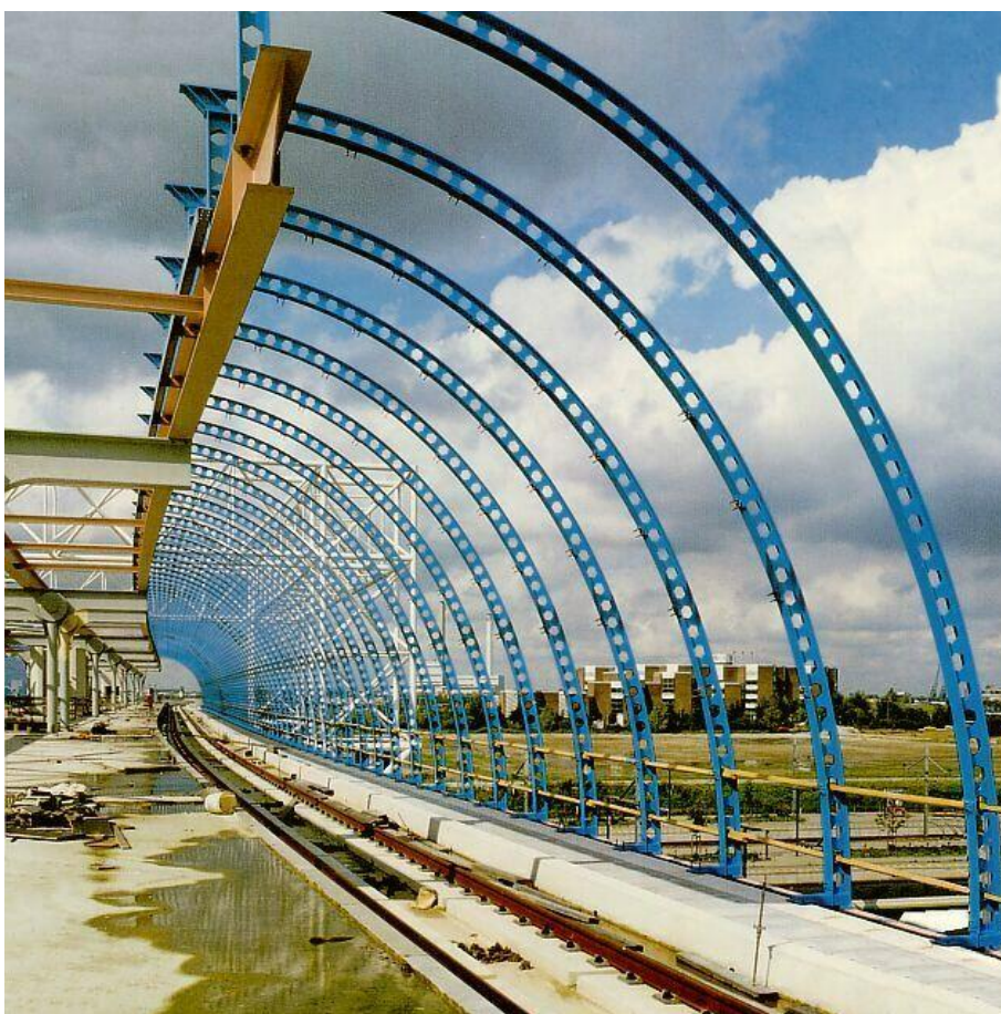
Σχήμα 1-10: Καμπυλωμένες δοκοί με διάκενα κορμού σε σιδηροδρομικό σταθμό στο Άμστερνταμ
