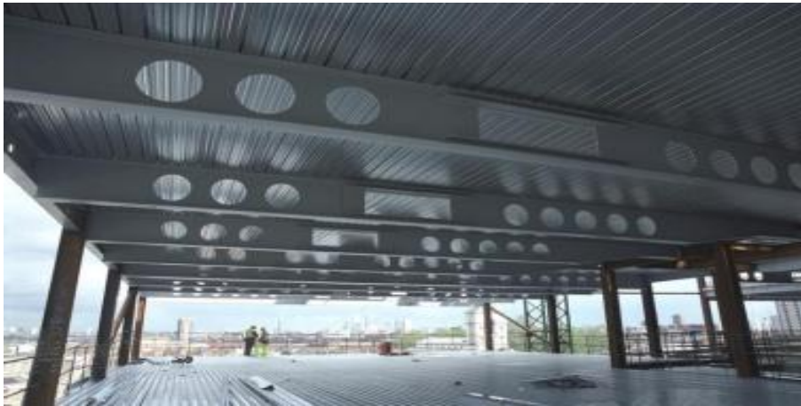
Σχήμα 2-2: Ενισχυμένο ορθογωνικό διάκενο
