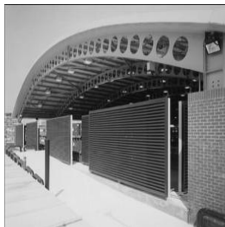
Σχήμα 1-20: Δοκοί με διάκενα κορμού σε εμφανείς θέσεις
