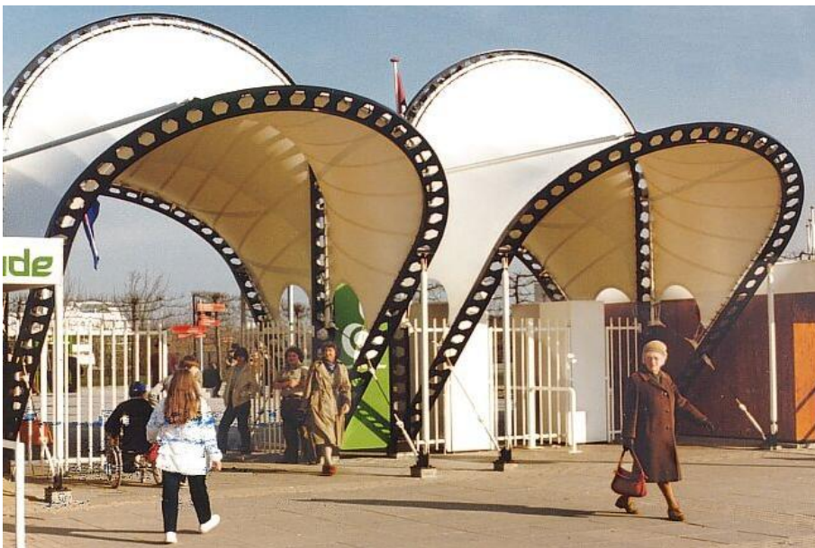
Σχήμα 1-11: Καμπυλωμένες δοκοί με κυκλικά διάκενα κορμού σε είσοδο πάρκου στο Άμστερνταμ
