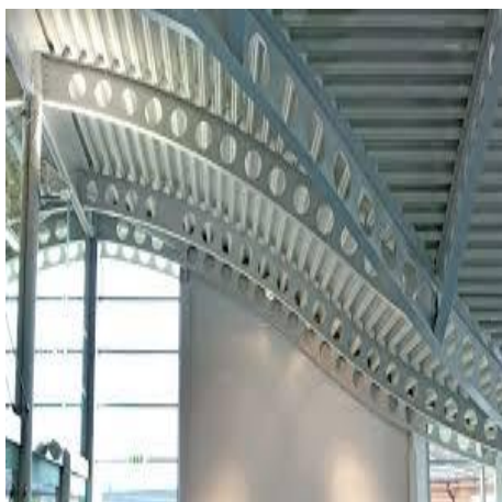
Σχήμα 1-20: Δοκοί με διάκενα κορμού σε εμφανείς θέσεις
