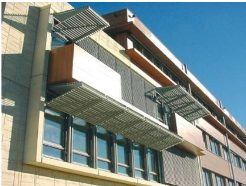
Εικ.3.19 Οριζόντιο σύστημα άρθρωσης - Πάνελ σκίασης
