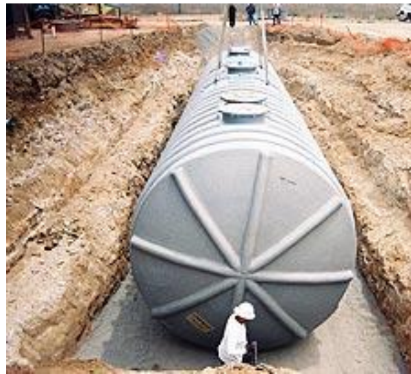
Εικόνα 3.3-9: Δοχείο θερμικής αποθήκευσης εντός του εδάφους
