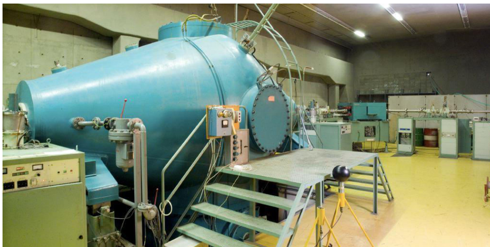
Εικόνα 2.1 Κεντρική δεξαμενή του επιταχυντή
