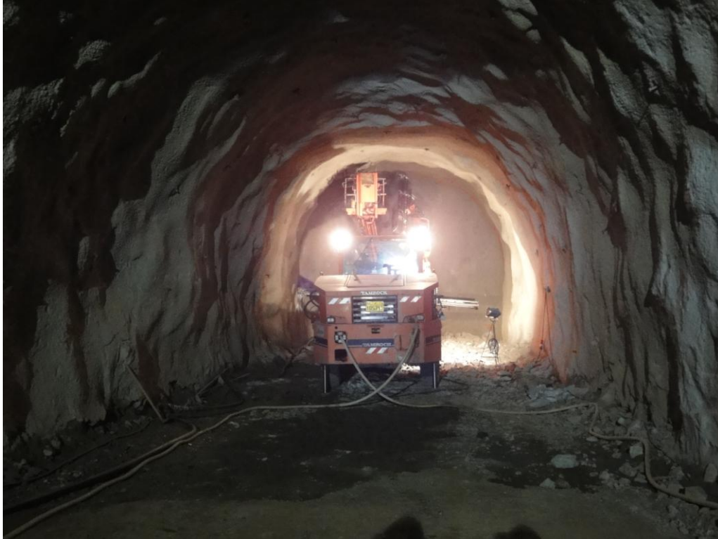
Εικόνα 3. Λιάτρωση στο μέτωπο προχώρησης
