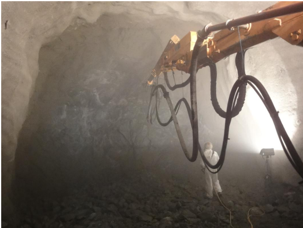
Εικόνα 8. Τοποθέτηση εκτοξευόμενου σκυροδέματος
