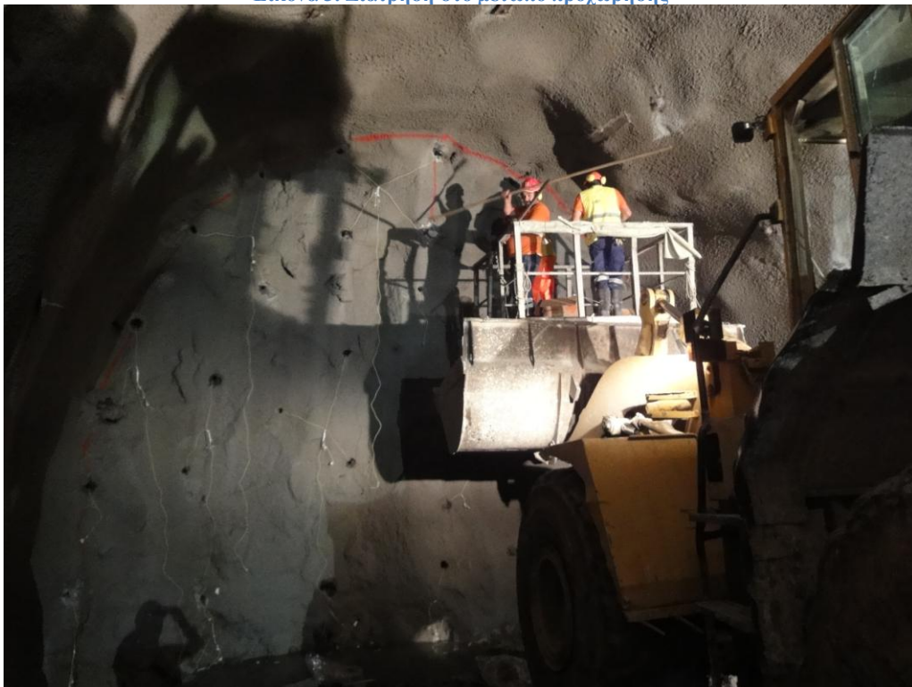
Εικόνα 4. Γόμωση διατρημάτων στο μέτωπο
