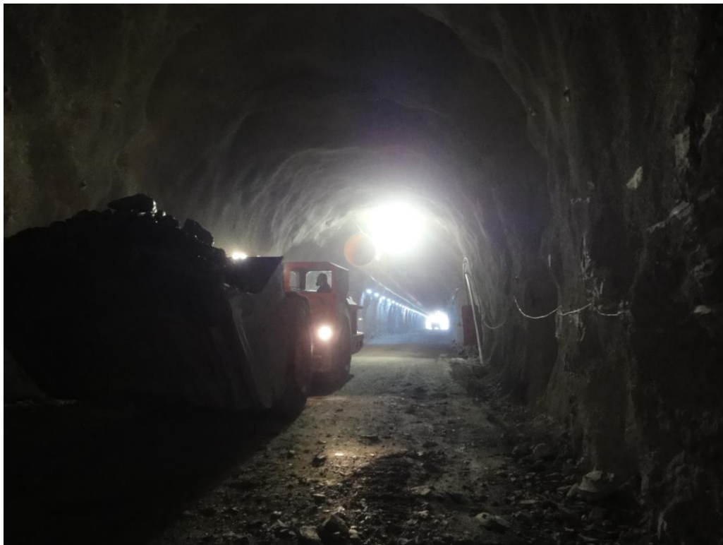
Εικόνα 6. Απομάκρυνση από το μέτωπο του υλικού που προέκυψε με την ανατίναξη
