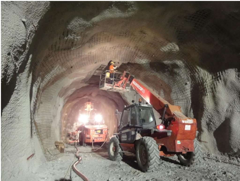
Εικόνα 10. Τοποθέτηση πλέγματος
