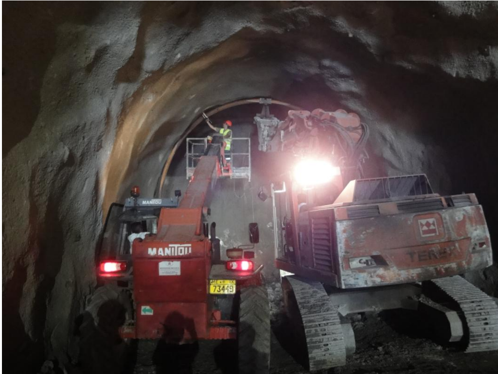
Εικόνα 9. Τοποθέτηση πλαισίου
