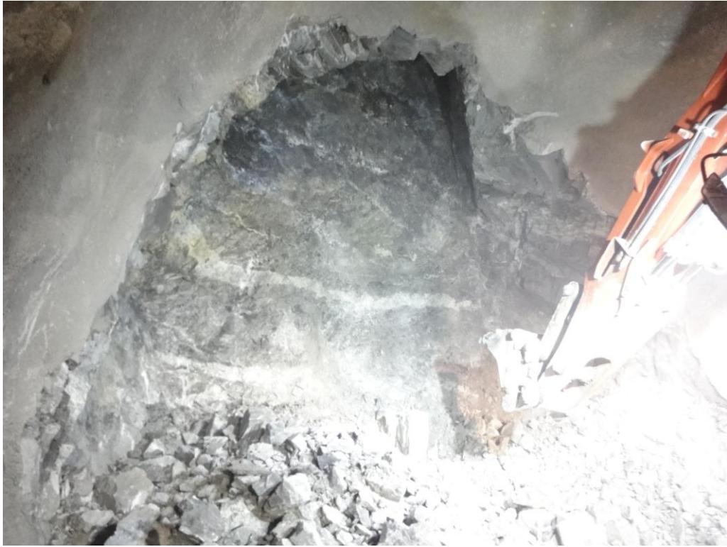
Εικόνα 7. Ξεσκάρωμα επισφαλών τεμάχων
