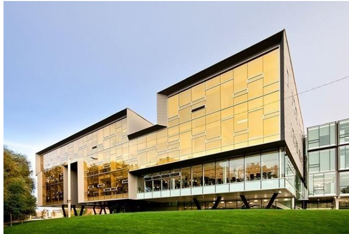
Σχήμα 3.10: Ανακλαστικοί υαλοπίνακες χρυσού χρώματος και μέτριας ηλιακής ανακλαστικότητας, της Pilkington (Pilkington Eclipse Gold).
