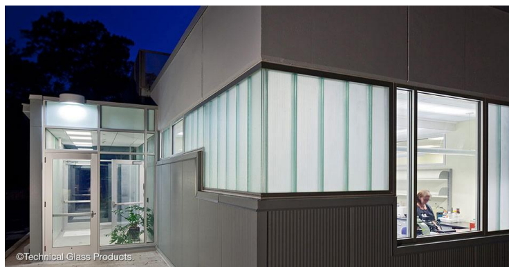
Σχήμα 3.22: Υαλοπίνακες με πλήρωση aerogel (από την Pilkington).
