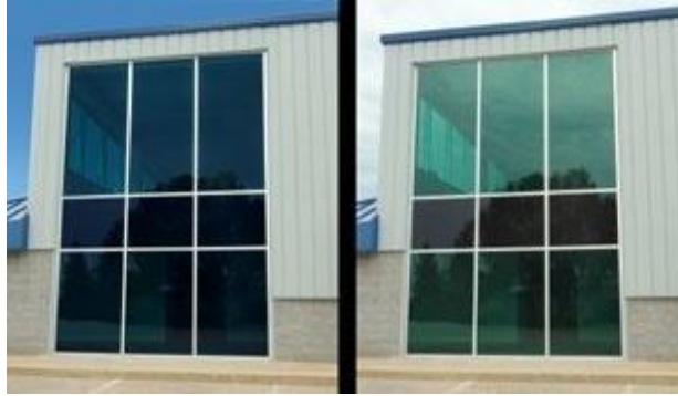
Σχήμα 4.17: Θερμοχρωμικοί υαλοπίνακες Suntuitive®. Αριστερά, σε κατάσταση ελάχιστης διαπερατότητας. Δεξιά, σε κατάσταση μέγιστης διαπερατότητας, καθώς η άμεση ηλιακή ακτινοβολία μειώθηκε.
