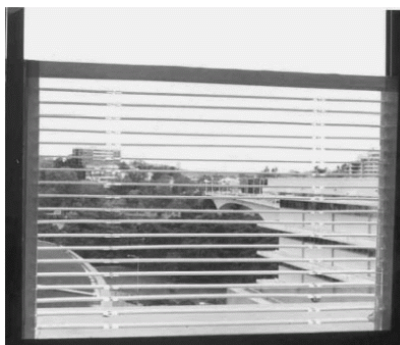
Σχήμα 3.20: Υαλοπίνακας ειδικής επεξεργασίας με laser.
