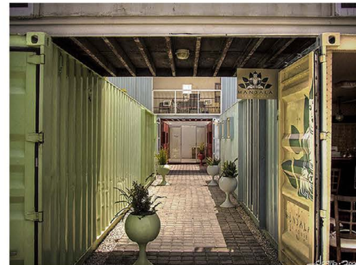
Crossbox/ Pont Péan/ Γαλλία/ Ολοκληρώθηκε το 2009/ CG Architects
