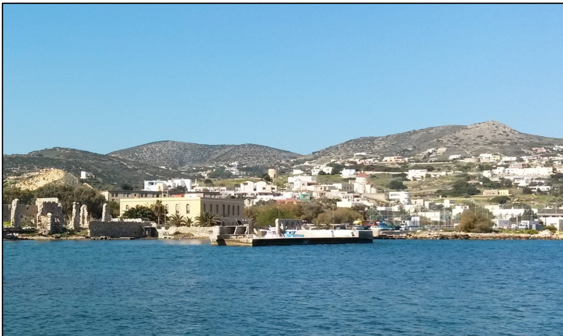
Εικόνα 33: Στο κέντρο της φωτογραφίας φαίνεται ο πρόβολος προστασίας του χειμάρρου
