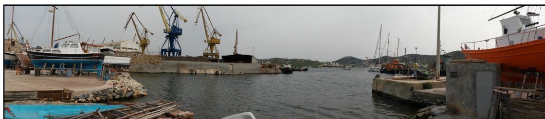
Εικόνα 16: Πανοραμική φωτογραφία στην οποία φαίνονται τα όρια του Νεωρίου-ταρσανά καθώς και τα όρια ταρσανά-αλιευτικού καταφυγίου
