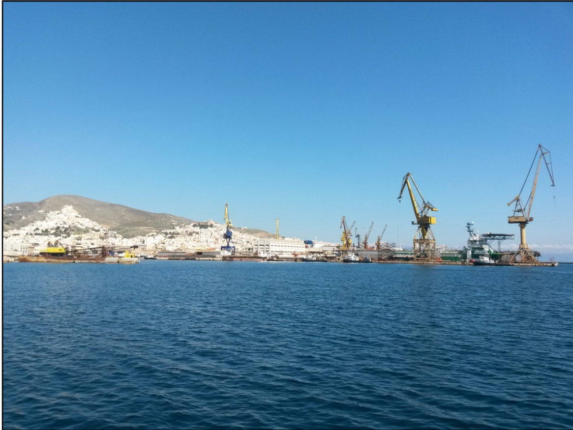
Εικόνα 12: Όψη Νεωρίου από τον Νότο
