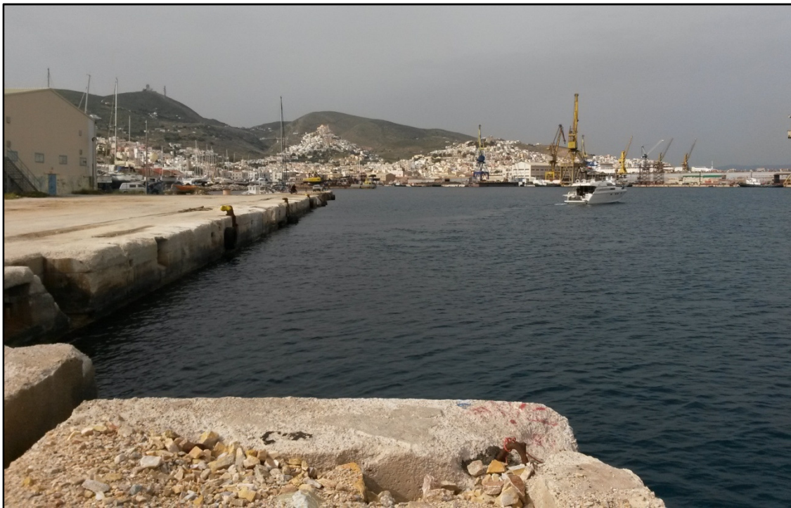
Εικόνα 28: Νότιο τμήμα εμπορικού κρηπιδώματος με υποτυπώδεις εγκαταστάσεις εξυπηρέτησης μικρών φορτηγών πλοίων
