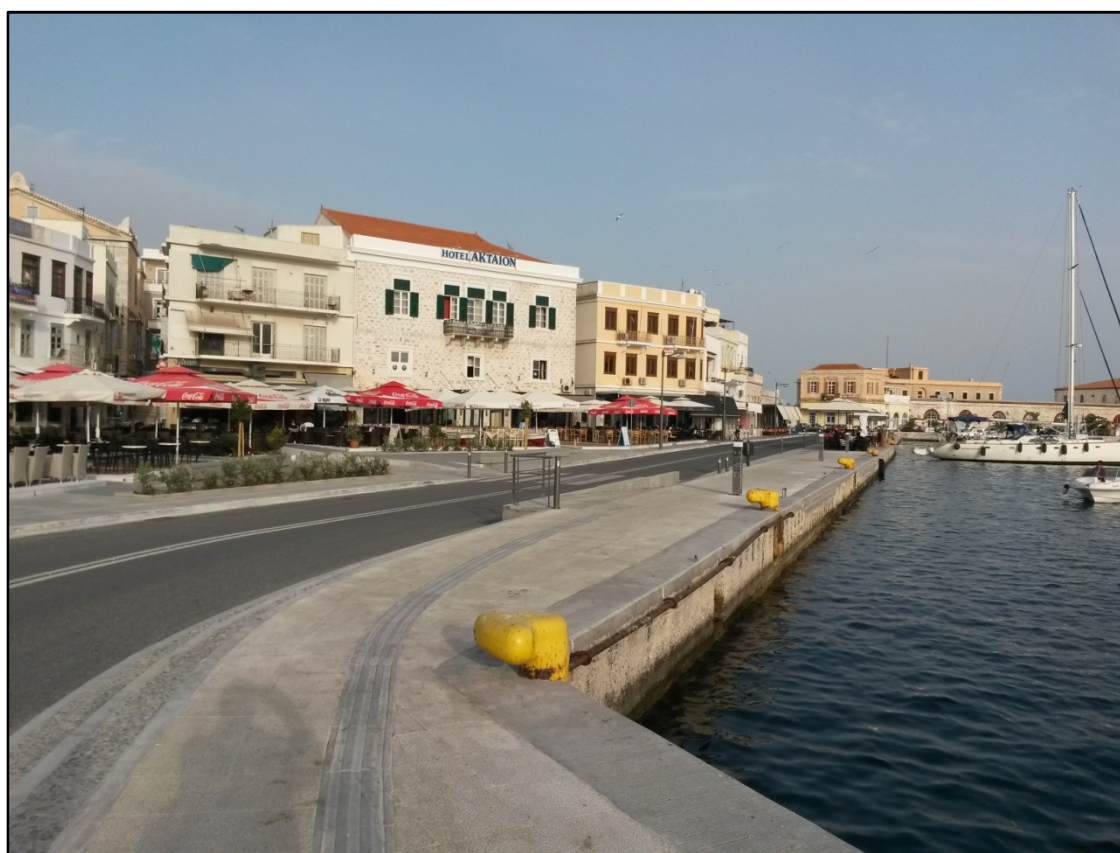
Εικόνα 4: Όψη κρηπιδώματος από σημείο 7 προς σημείο 6 μετά την ολοκλήρωση της ανάπλασης
