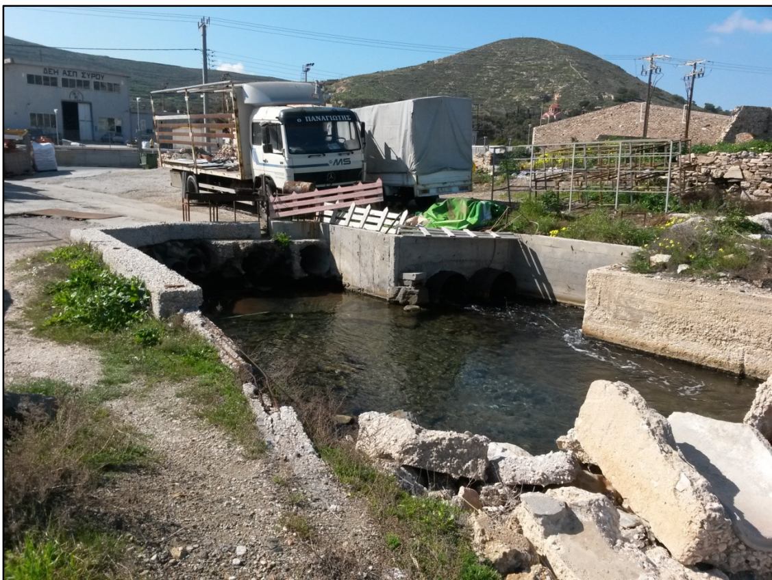
Εικόνα 35: Εκροή υδάτων συστήματος ψύξης του ΑΣΠ της ΔΕΗ
