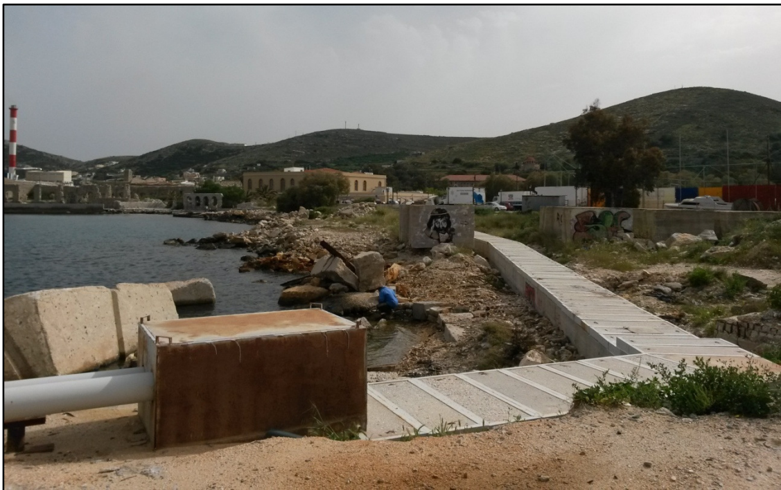
Εικόνα 30: Προστασία όδευσης αγωγού καυσίμων νοτίως του κρηπιδώματος
