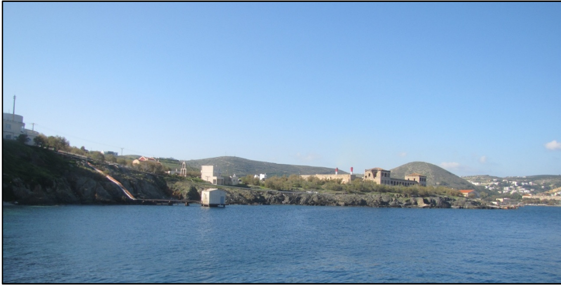
Εικόνα 41: Φυσική βραχώδης ακτή στην οποία φαίνεται και το αντλιοστάσιο της SEKAVIN
