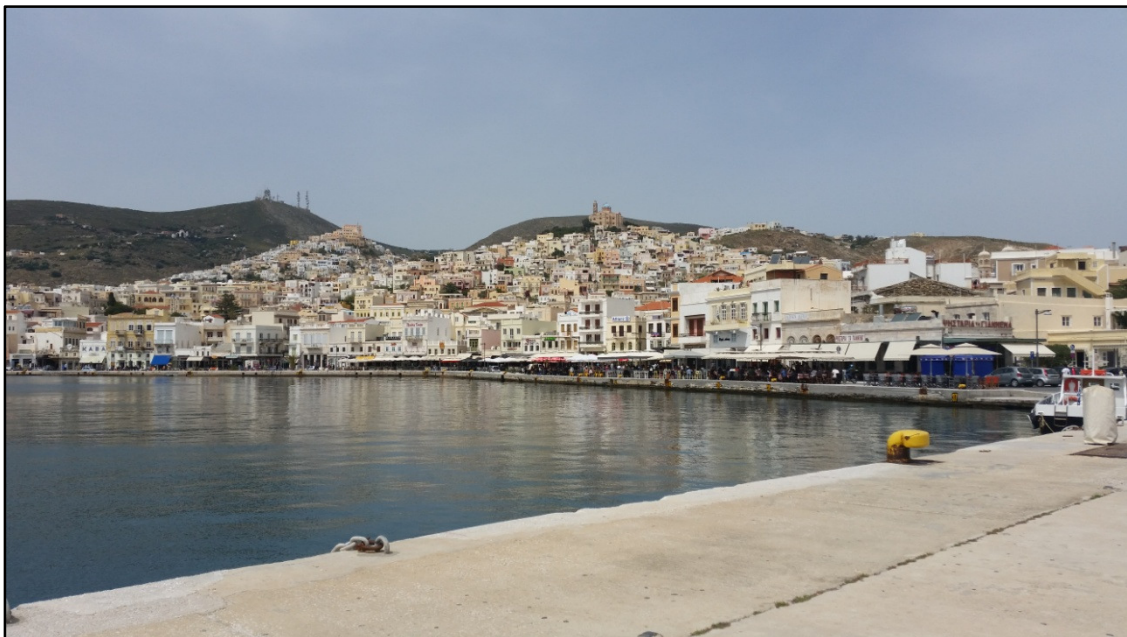
Εικόνα 6: Όψη κρηπιδώματος 6-7 και 7-8
