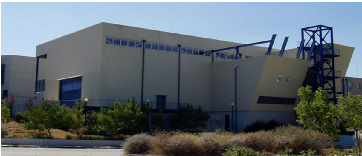
Εικ. 6.1 προοπτική όψη του Εργαστηρίου Μεταλλικών Κατασκευών (πηγή www.labmetalstructures.civil.ntua.gr )
