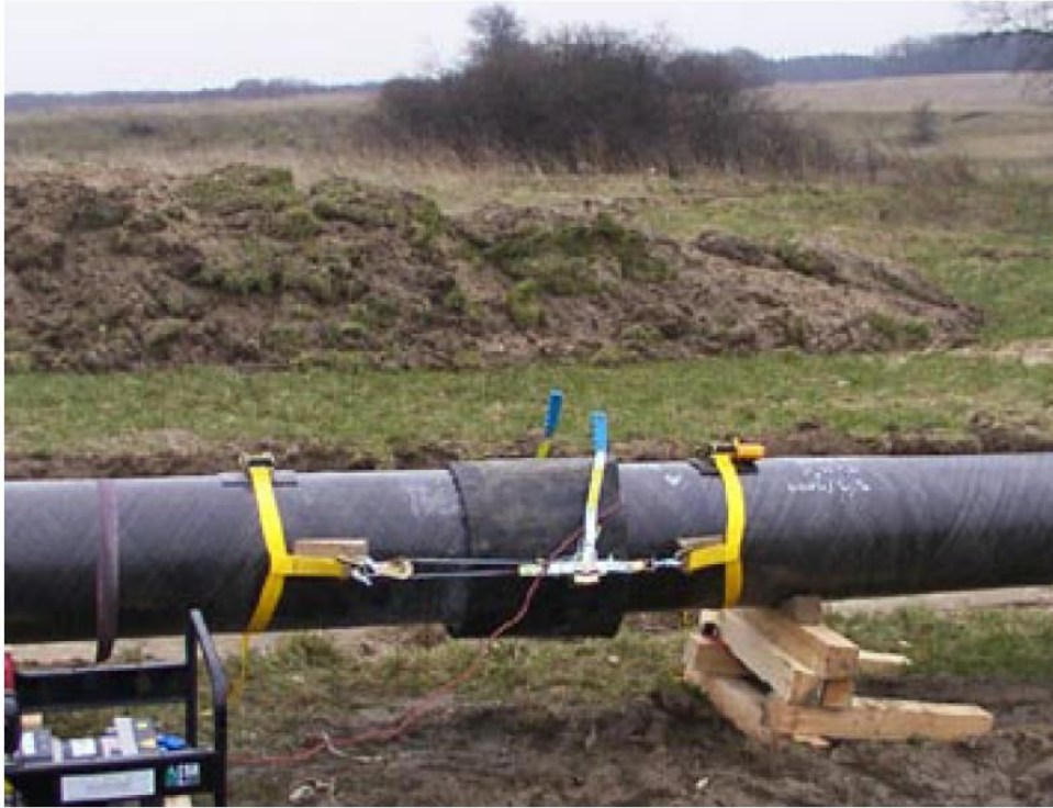
Σχήμα 3.29: Εφαρμογή εξωτερικής δύναμης για την συναρμολόγηση σωληνώσεων FRP, AMERON 2011
