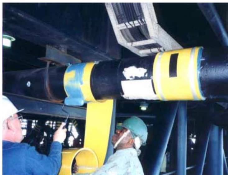
Σχήμα 1.7: Σωλήνωση GRE της AMERON σε πλατφόρμα άντλησης πετρελαίου
