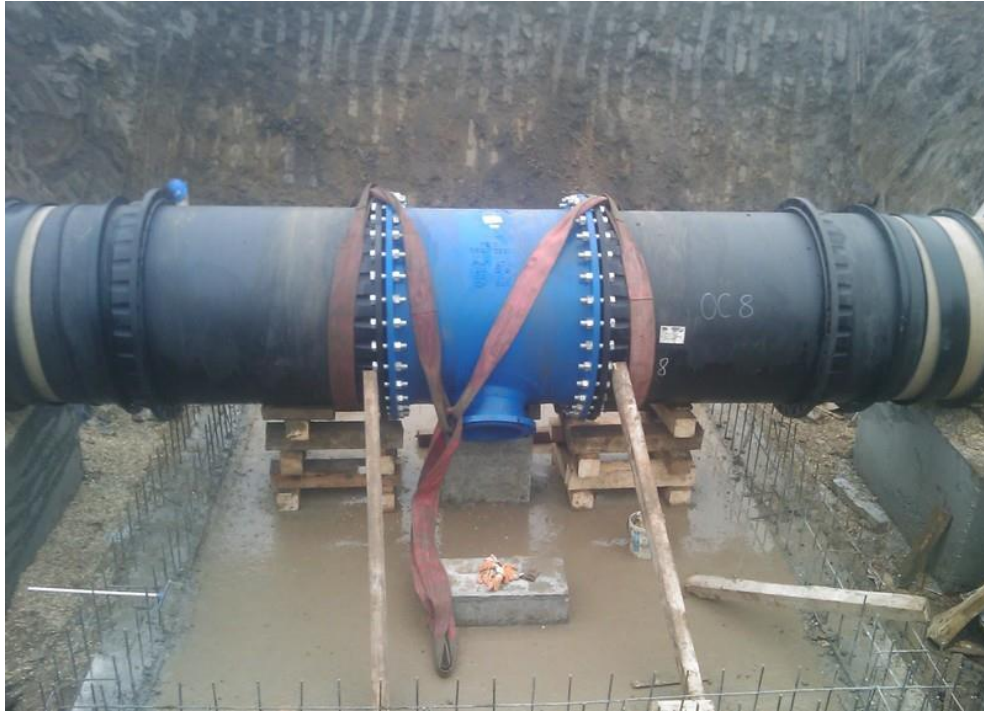
Σχήμα 3.31: Μηχανική σύζευξη Viking Johnson
