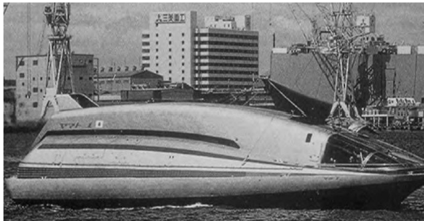
Σχήμα 13: Το πειραματικό πλοιάριο Yamato 1 με ηλεκτρομαγνητική πρόωση. [13]
