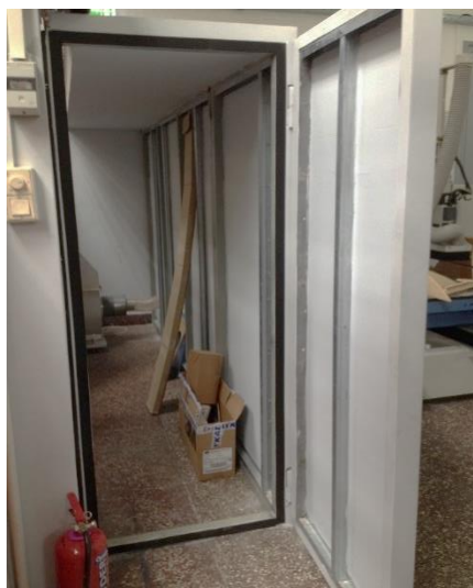
Εικόνα 5.14 – Ειδικός χώρος για τις σκούπες αναρρόφησης (κουβούκλιο)
