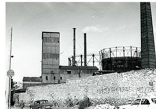
Εργοστάσιο Φωταερίου στο Γκάζι. Πηγή: http://www.misanitoursoy.gr
