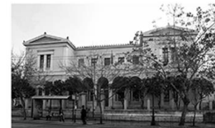
Από τη συνεχή σειρά των νεοκλασικών κτιρίων πολύ λίγα διατηρήθηκαν. Ένα από αυτά είναι το Δημοτικό Θρησκευτήριο (1874), το οποίο στεγάζει σήμερα τη Δημοτική Πινακοθήκη. Πηγή: Προσωπικό αρχείο
