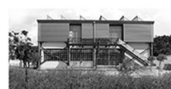
Προσθήκη μεταλλικής κατασκευής για τη στέγαση του Μεταπτυχιακού Τμήματος. Πηγή: http://www.ktiro.gr
