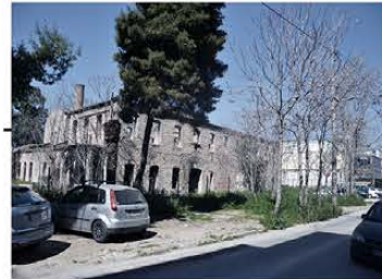
Παλιό εργοστάσιο ΒΟΤΡΥΣ_διασάθρωση Σιάκου και Αυλίκου
