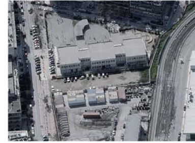
A3_ αδόμητος χώρος επί της Χατζηασπασίου _ιδιοκτησία: Αττικό Μετρό Α.Ε _χρήση: καμία
