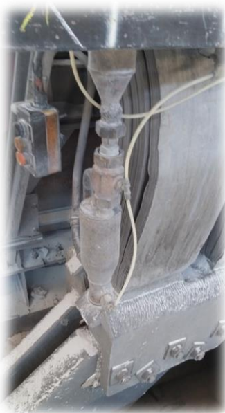
Εικόνα 19: Δοσίμετρο τροφοδοσίας φθοριούχου αλουμινίου
