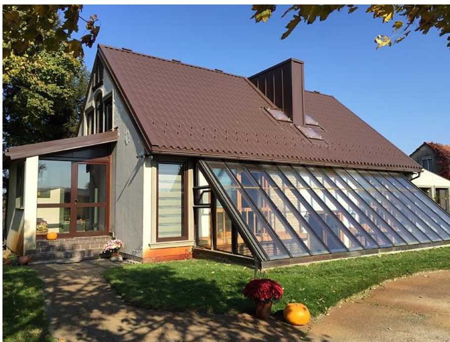
Εικόνα 1.2 : Ενσωμάτωση ηλιακού χώρου σε κατοικία [3]
