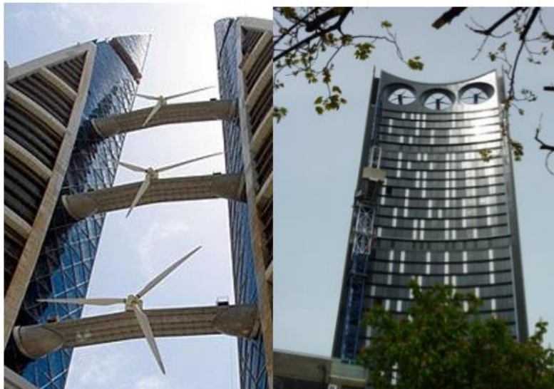
Εικόνα 2.12 : Α/Γ ενσωματωμένες στα κατασκευαστικά χαρακτηριστικά του κτιρίου [24]
