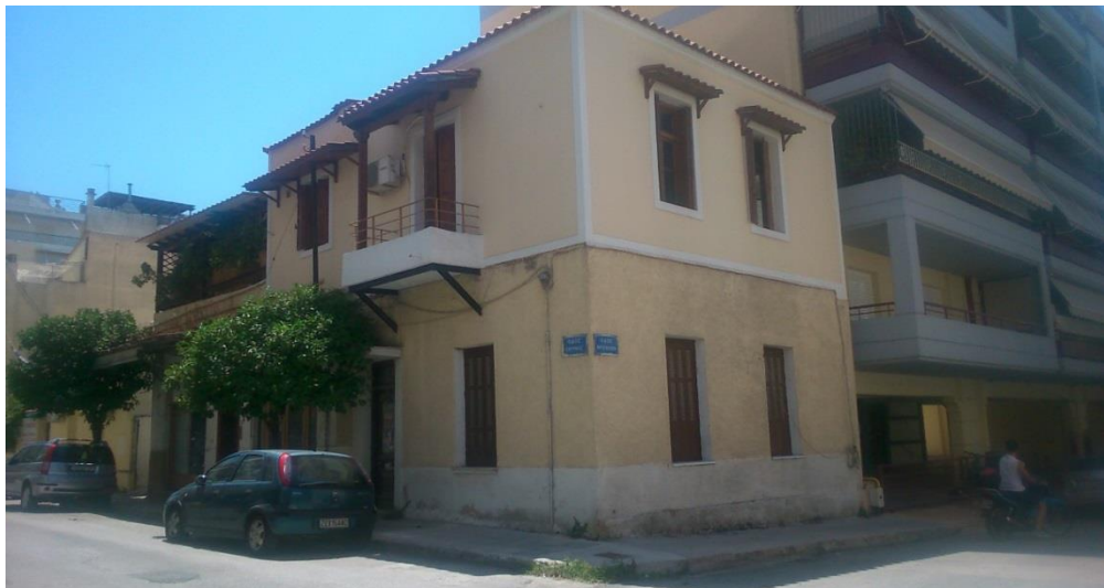
Εικόνα 33: Διώροφη κατοικία (7) στην συμβολή των οδών Σμύρνης και Βρυούλων
