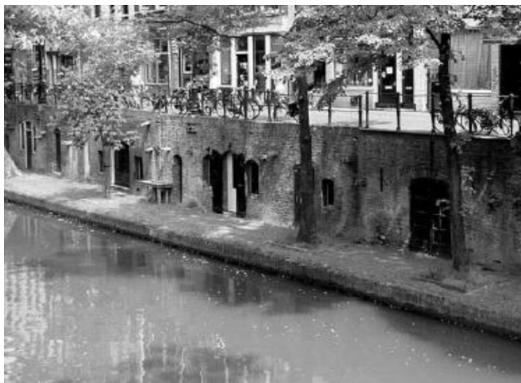
Εικόνα 14: Πολυεπίπεδη χρήση γης στο Rotterdam, ύπαρξη αποθηκών στα υπόγεια δρόμων (πηγή Stoter, 2004)
