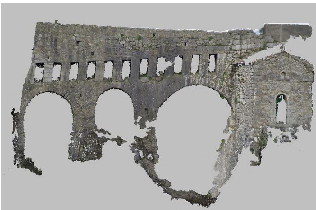
Εικόνα 4.20: Νέφος σημείων μέσω του MicMac
