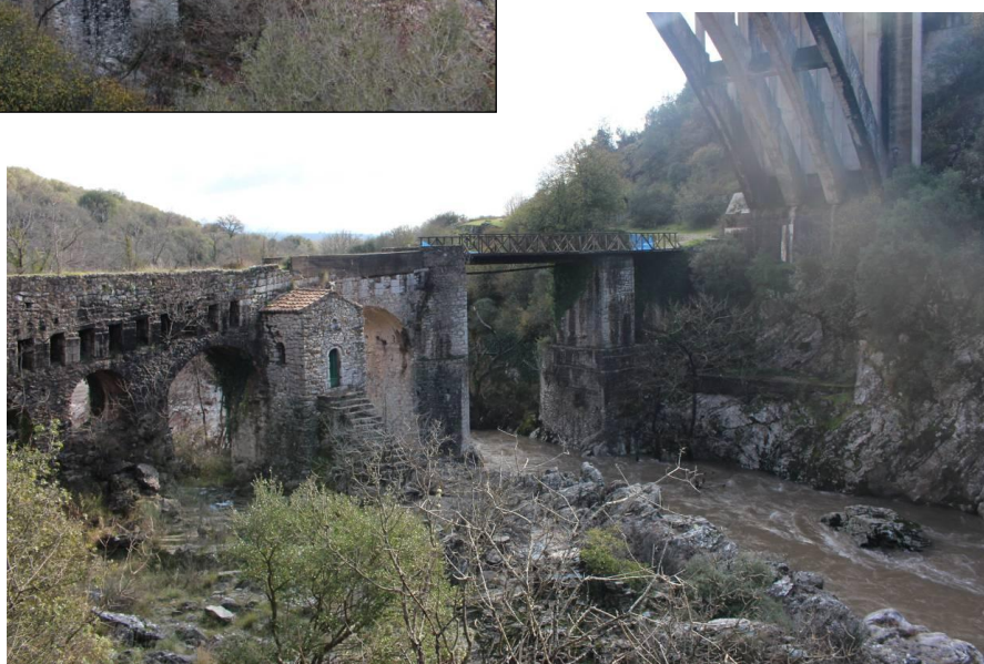
Εικόνα 4. 6: Γενική άποψη της περιβάλλοντα χώρου του γεφυριού Πάνω: Ανατολική όψη, Κάτω: Δυτική όψη
