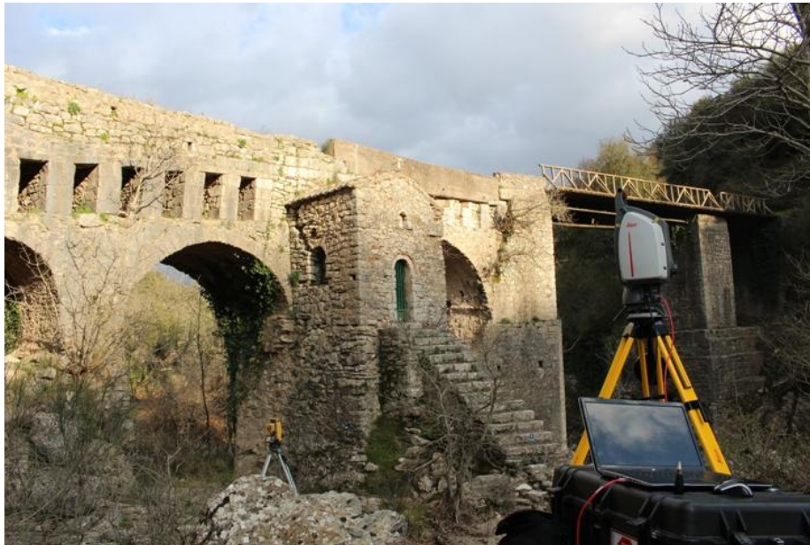
Εικόνα 4.11: Θέση σαρωτή laser επί το πεδίο
