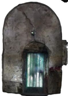
Δυτική εσωτερική όψη
