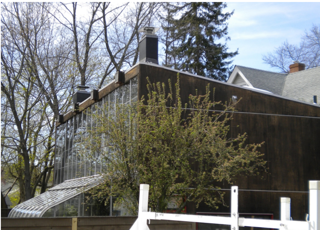
Εικόνα 20. Πρόσοψη και Πλάγια όψη
