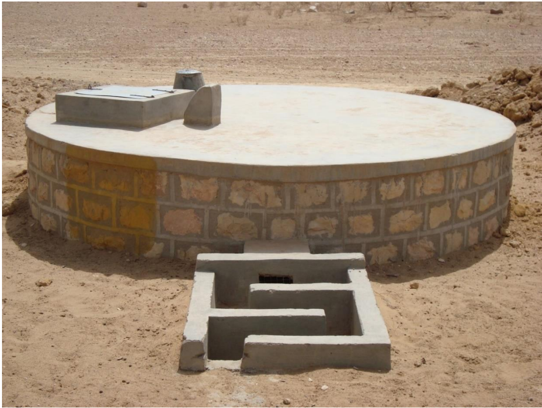
Σχήμα 2.7: Παραδοσιακή δεξαμενή συλλογής βρόχινου νερού στην Ινδία (Πηγή: https://upload.wikimedia.org/wikipedia/commons/d/db/Rainwater_harvesting_tank,_India.jpg )
