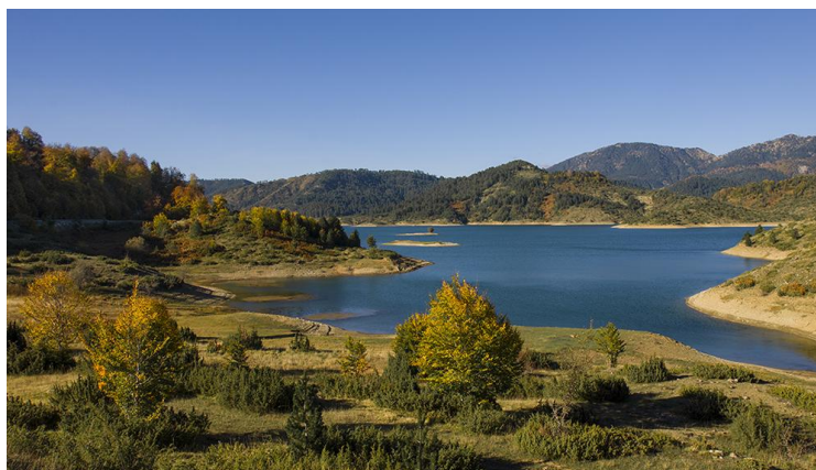
Εικόνα 4.1: Τεχνητή λίμνη πηγών Αώου
