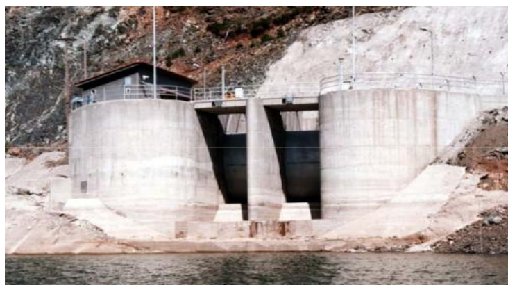
Εικόνα 4.5: Εκχειλιστής και θυροφράγματα του ΥΗΣ Πηγών Αώου
