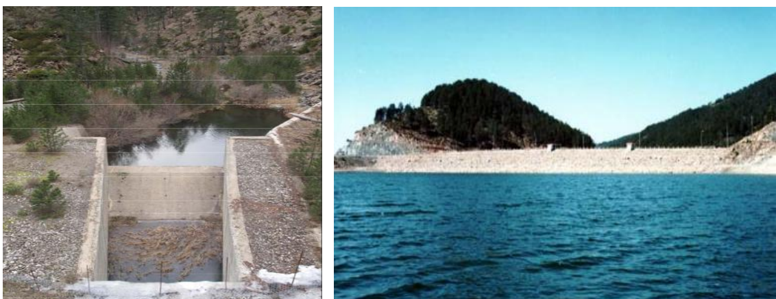
Εικόνα 4.4: Κύριο φράγμα και σήραγγα εκτροπής στην παλιά κοίτη Αώου
