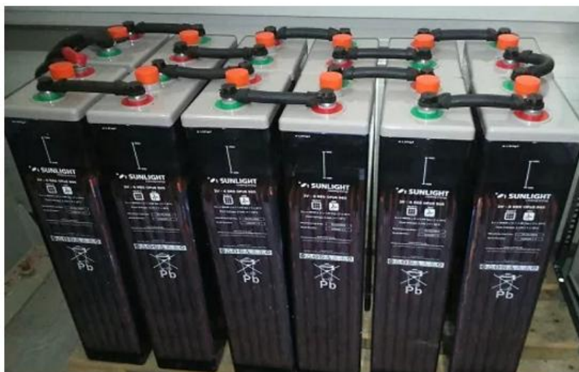
Εικόνα 5.3 : Τύπος συσσωρευτών που χρησιμοποιούνται σε αυτόνομο Φ/Β σύστημα (Πηγή: https://www.mp-energy.gr )
