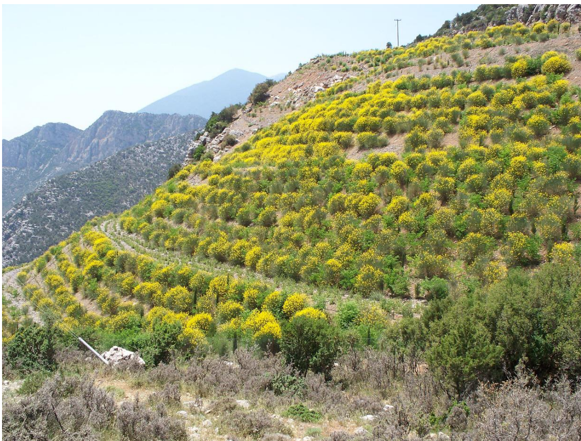
Εικόνα 11. Ροδιά: Αποκατάσταση Μεταλλευτικού Χώρου στη θέση Ροδιά, έργο από «ΔΕΛΦΟΙ – ΔΙΣΤΟΜΟ Α.Ε.»
