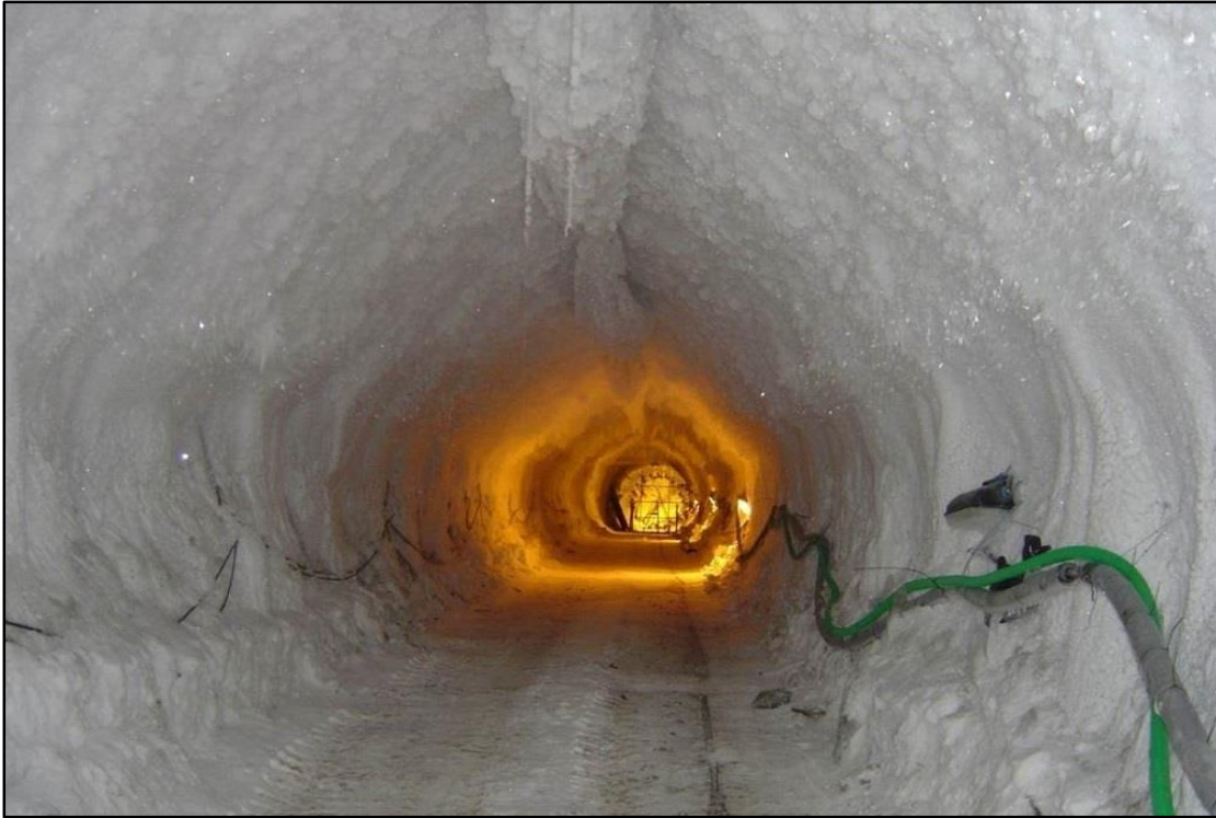
Εικόνα 1-4 Βελτίωση δυσμενούς υπεδάφικης ζώνης στη Σουηδία με το πάγωμα των κεκορεσμένων χαλαρών υλικών
