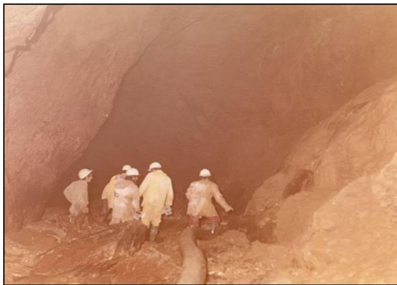
Εικόνα 1-9 Καρστικό που συναντήθηκε στη σήραγγα της Γκιώνας (τρόπος αντιμετώπισης: παράκαμψη) (Μαρίνος 2009).
