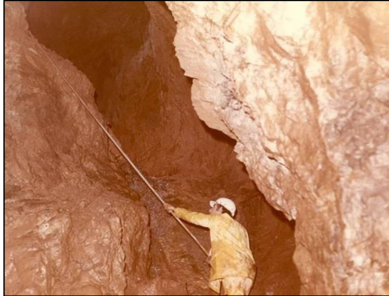
Εικόνα 1-8 Καρστικό που συναντήθηκε στη σήραγγα της Γκιώνας (τρόπος αντιμετώπισης: γεφύρωση) (Μαρίνος 2009).
