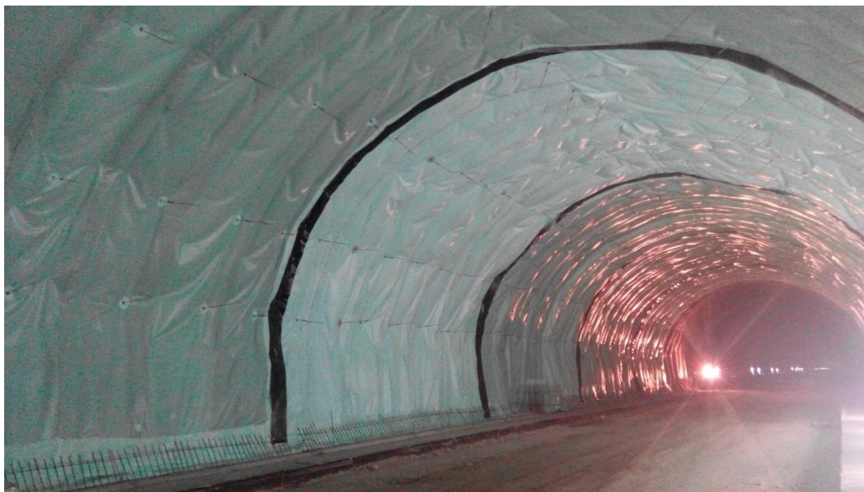
Εικόνα 1-6 Τοποθετημένη πλαστική μεμβράνη στην οδική σήραγγα Τεμπών.
