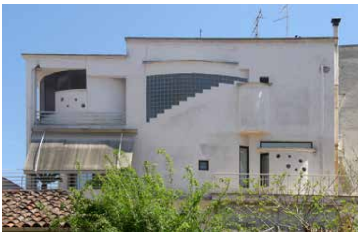
Εικ. 67-68. (πάνω) Το οικόπεδο σήμερα με το καινούριο και το παλιό σπίτι και (κάτω) λεπτομερεια της όψης του πανωσηκώματος.
