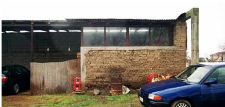
Εικ. 19-21. Πλίθινα κτίσματα με επιφανειακές ή στατικές επισκευές με σύγχρονα υλικά: (πάνω) μονώροφο πλίθινο με σύγχρονες επεμβάσεις στο εξωτερικό, (στη μέση) διώροφο πλίθινο με ανακατασκευασμένο χαγιάτι από μπετόν και (κάτω) πλίθινη αποθήκη με σύγχρονες προσθήκες από μπετόν, σίδερο, τσίγκο και τσιμεντόλιθους.
