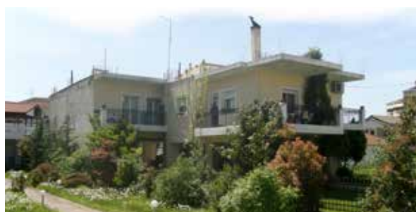
Εικ. 43-45. Εξωτερικές όψεις του σπιτιού.
