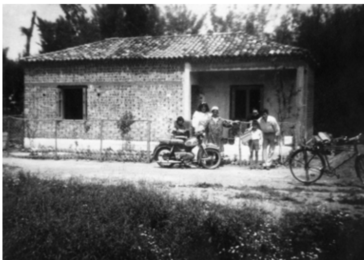
Εικ. 35-36. Πρώτες εφαρμογές φέρουσας τοιχοδομής από τούβλα σε συνδυασμό με φέροντα στοιχεία από μπετόν σε κατοικίες στο Αγναντερό Καρδίτσας (δεκαετία του '60): (πάνω) σύγχρονη παραλλαγή του τύπου «Γ» που συνθίζονταν στα πλίνθινα και (κάτω) απλούστερος τύπος κατοικίας με τη χαρακτηριστική βεράντα και την κολώνα στη γωνία.
