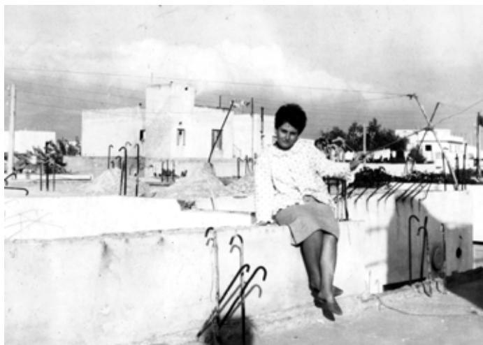
Εικ. 40-41. Αναμονές και ενδείξεις της πρόθεσης για κατακόρυφη επέκταση (πάνω) σε αυθαίρετες κατασκευές στα περίχωρα της πόλης και (κάτω) σε μικροαστικές κατοικίες στο κέντρο.
