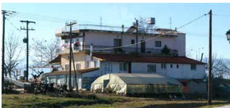
Εικ. 24-26. Το σπίτι όπως είναι σήμερα, μετά από τις διάφορες προσθήκες: (πάνω) όπως φαίνεται από το δρόμο, (στη μέση) η πλαϊνή όψη και (κάτω) η πίσω πλευρά.
