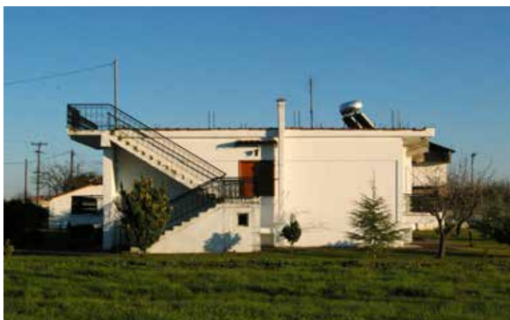
Εικ. 43-44. Παραδείγματα των πρώτων δώροφων κατοικιών με σκελετό από μπετόν και δυνατότητα για κατακόρυφη επέκταση, καθώς και σαφέστερη μορφολογική σχέση με το πρότυπο της πολυκατοικίας. (Αγναντερό Καρδίτσας.)
