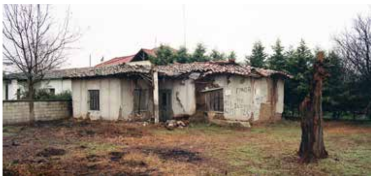
Εικ. 16-18. Παραλλαγές της τυπικής παραδοσιακής πλιθινης κατοικίας στα χωριά του Θεσσαλικού Κάμπου (Αγναντερό Καρδίτσας): (πάνω) τυπικό μακρόστενο συμμετρικό σπίτι με χαγιάτι, (στη μέση) το ίδιο με προσκτίσματα σε μήκος και (κάτω) παραλλαγή σε σχήμα «Γ» με το χαγιάτι στη γωνία.
