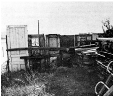
Εικ. 42-44. Χειροποίητες ιδιοκατασκευές με σύγχρονα υλικά και αρχιτεκτονικά στοιχεία σε δεύτερη χρήση σε περιοχές αυθαιρέτων οικισμών: (πάνω) Αποθηκευτικοί χώροι και σταύλοι/κοτέτσια από κομμάτι τσίγκου και (δεξιά) φράχτης από μεταχειρισμένα φύλλα παραθύρων και πόρτες.
