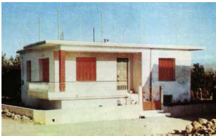
Εικ. 41-42. Πρώιμα δείγματα λαϊκών κατοικιών με πλήρη σκελετό από μπετόν (πάνω) στην περιφέρεια της Αθήνα και (κάτω) στην επαρχία, φωτογραφημένα από τον Ιωάννη Λυγίζο στις αρχές της δεκαετίας του '70.
