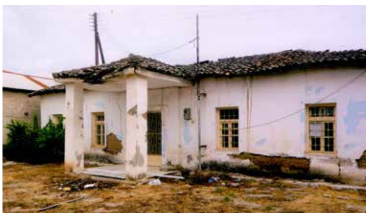
Εικ. 22-23. (πάνω) Το καινούριο σπίτι, σύντομα μετά την ολοκλήρωση της βασικής κατασκευής και (κάτω) το παλιό, πατρικό σπίτι, λίγο πριν την κατεδάφισή του. (Φωτογραφίες του ιδιοκτήτη τους.)
