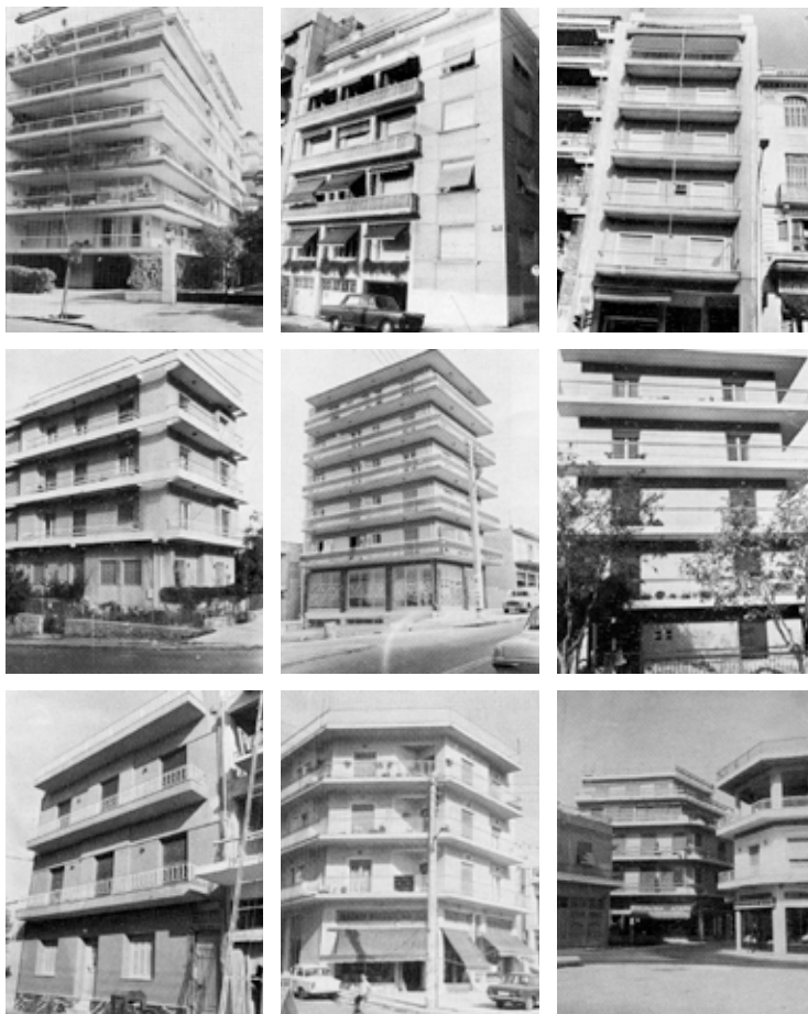
Εικ. 12-20. Παραλλαγές του κυρίαρχου μοντέλου της πολυκατοικίας από περιπτώσεις υψηλών εισοδημάτων στο κέντρο της Αθήνας μέχρι χαμηλότερων στα προάστια. (Φωτογραφίες Β. Βαφειάδη στη δεκαετία του '70.)
