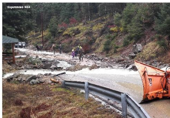
Εικόνα 4.37: Φαινόμενα διάβρωσης στην περιοχή του Κρανορέματος. Η καταστροφή του οδοστρώματος σε μεγάλη έκταση δυσχέρανε τη διαδικασία εκκένωσης του οικισμού (Πηγή: Ευρυτανικά Νέα).
