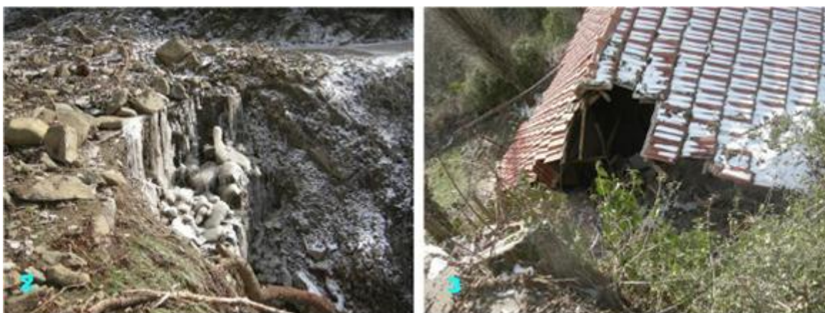
Εικόνα 4.7 Καταγεγραμμένες ζημιές εντός του οικισμού λόγω της ροής. Απόθεση των υλικών της ροής στο οδόστρωμα (Αριστερά). Καταστροφής οικίας από ογκολίθους που μεταφέρθηκαν μέσω του ρέματος και του δρόμου (Δεξιά), (Κωσταντοπούλου & Κανάρης, 2015).
