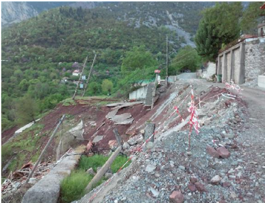
Εικόνα 4.12: Άποψη της κύριας κατακρήμνισης της κύριας κατολίσθησης στον οικισμό Κάτω Κλεπά.
