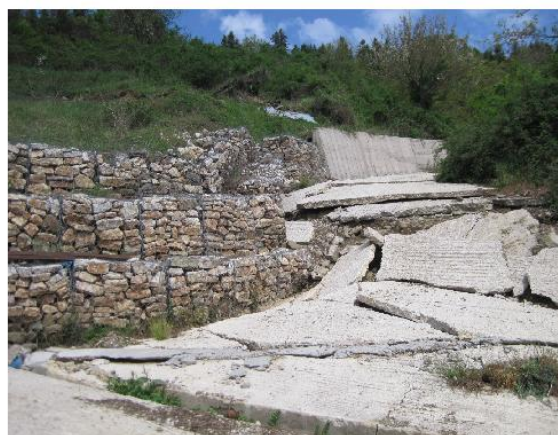
Εικόνα 4.35: Αναγνώριση του πόδα της καταγεγραμμένης κατολίσθησης στη Θέση ΚΡ1. Η υπό εξέταση περιοχή χρήζει αποκατάσταση (πάνω εικόνα). Αποψη του κύριου όγκου της κατολίσθησης (κάτω εικόνες).
