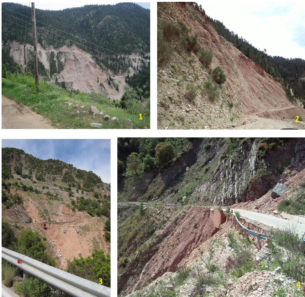
Εικόνα 4.32: Ροή κερατολίθου πλησίον του οικισμού Κοκκινόβρυση (εικόνες 1 & 2). Σύνθετη κατολίσθηση πλησίον της γέφυρας Γιδομανδρίτη. Ξεκίνησε ως περιστροφική και στη συνέχεια εξελίχθηκε σε μεταθετική (εικόνες 3 & 4).
