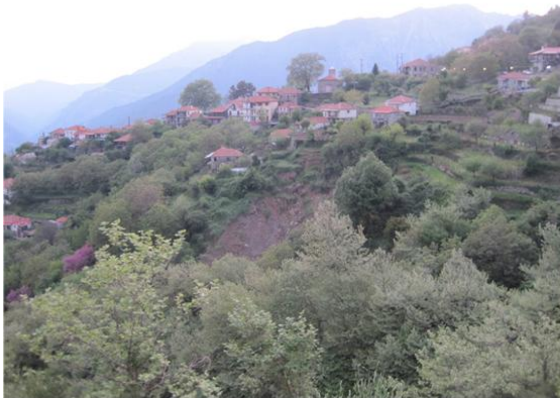
Εικόνα 4.18: Άποψη της κατολίσθησης στη θέση 2.
