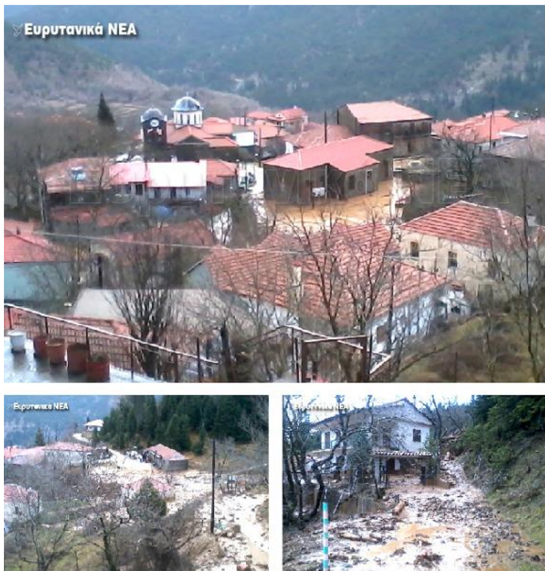
Εικόνα 4.36: Απόψεις της περιοχής που πλήχτηκαν από το φαινόμενο της ροής λάσπης. Στην πάνω εικόνα διακρίνεται η περιοχή του σχολείου και της εκκλησίας του Αγίου Νικολάου (Πηγή: Ευρυτανικά Νέα).
