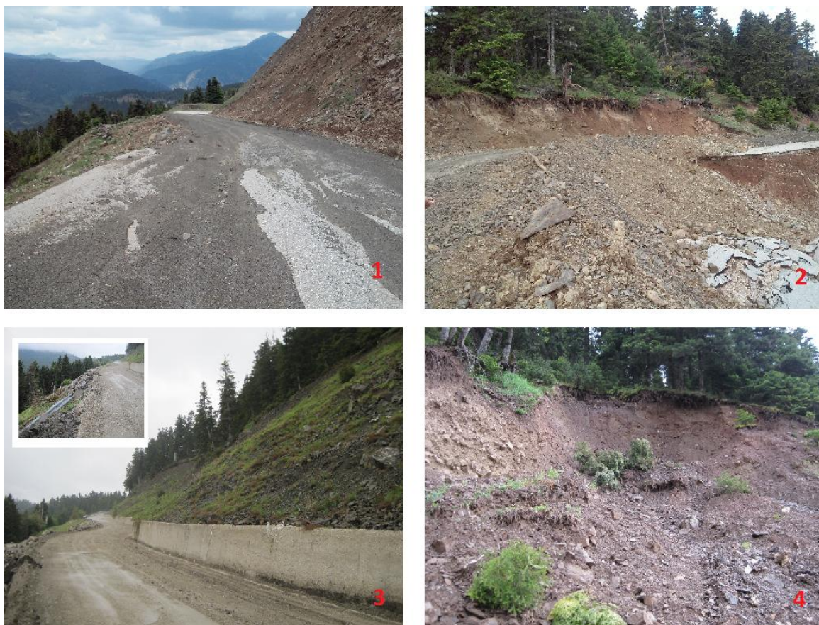
Εικόνα 4.42: Καταγεγραμμένες κατολισθήσεις επί του επαρχιακού δικτύου του Δήμου Καρπενησίου.
