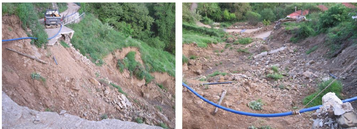
Εικόνα 4.17: Στέψη και αριστερή πλευρά της κατολίσθησης. Διακρίνεται ο αποκοπτόμενος δρόμος (Αριστερά). Κύριο σώμα κατολίσθησης (Δεξιά).
