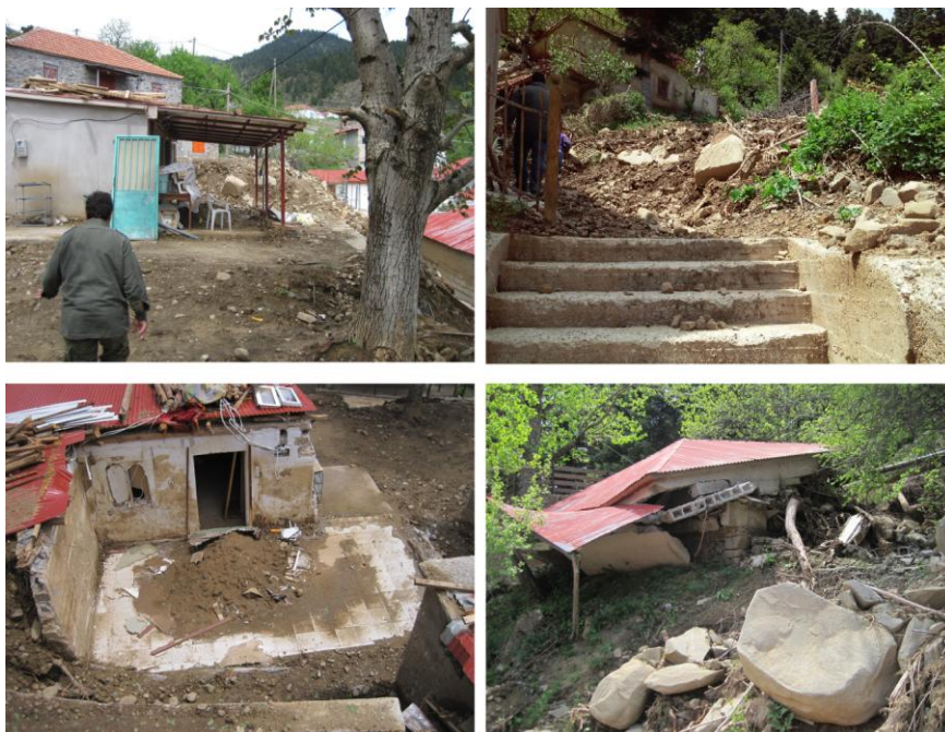
Εικόνα 4.39: Απόψεις του οικισμού και των εκτεταμένων ζημιών που προκλήθηκαν από τη ροή γαιών.
