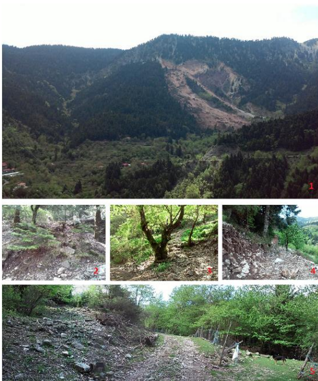
Εικόνα 4.27: Γενική άποψη της κατολίσθησης στον οικισμό Νεροσύρτης. Διακρίνεται η νέα & η παλιά κατολίσθηση (εικόνα 1). Ροές υλικών σε διάφορες περιμετρικές θέσεις του πόδα της εξεταζόμενης κατολίσθησης (εικόνες 2, 3 & 4). Λήψη του πόδα της κατολίσθησης επί αγροτικού δρόμου (εικόνα 5).
