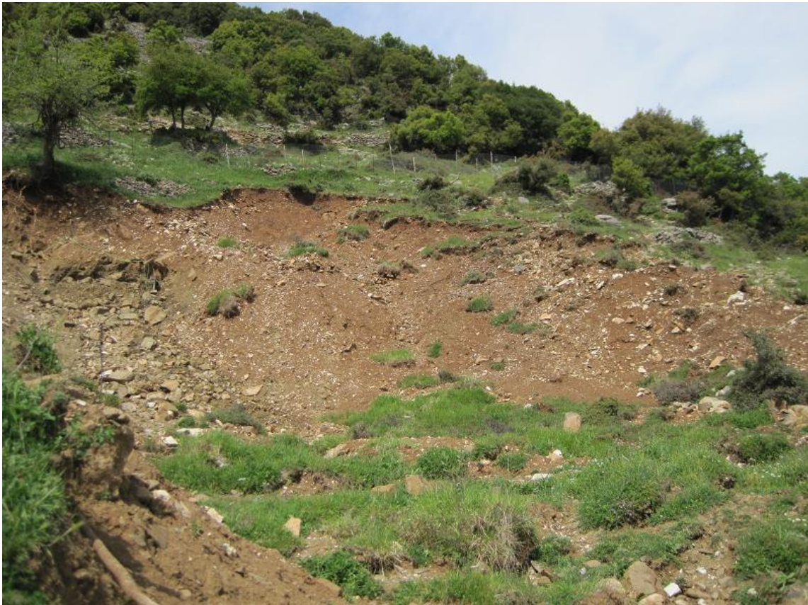
Εικόνα 4.29: Γενική άποψη της κατολίσθησης στη θέση ΘΕ14.
