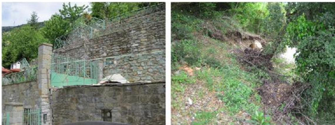
Εικόνα 4.4 Επαφή Εύκαμπτης και Άκαμπτης κατασκευής στην υπό εξέταση οικία στη θέση ΠΕ1 (Αριστερά). Αναγνώριση της κατακρήμνισης στη θέση ΠΕ1 (Δεξιά).
