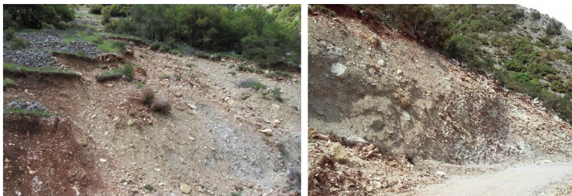
Εικόνα 4.30: Γενική άποψη της κατολίσθησης στη θέση ΘΕ15.
