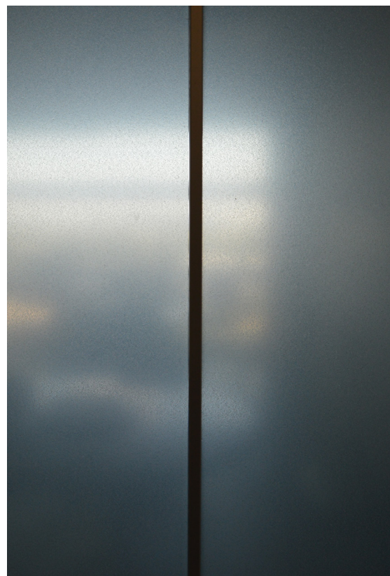
Εικόνα 5.3.3- Λεπτομέρεια κατακόρυφου αρμού υαλοπετάσματος τύπου Α.
