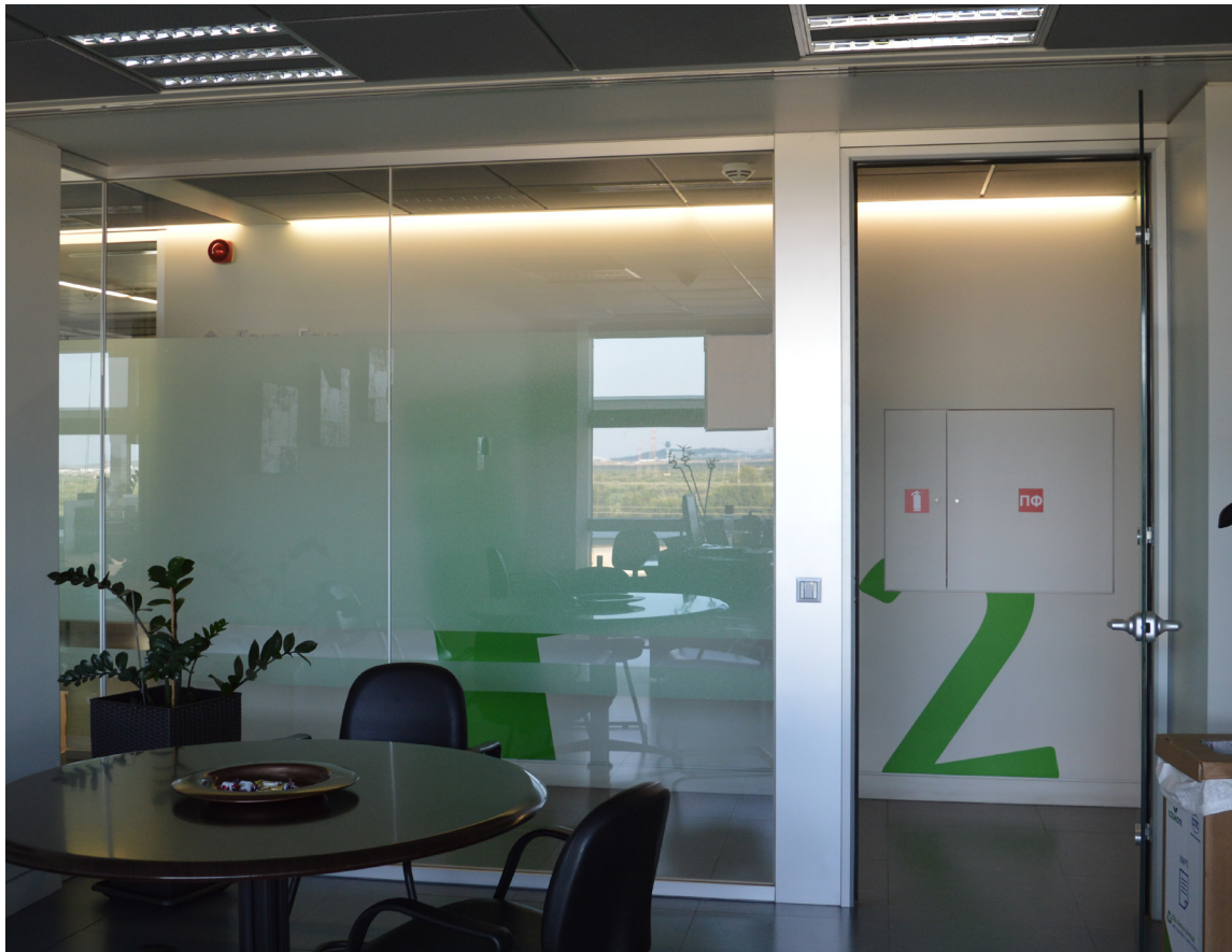
Εικόνα 5.3.1- Άποψη υαλοπετάσματος F212.2 - γραφείο F212.2.
