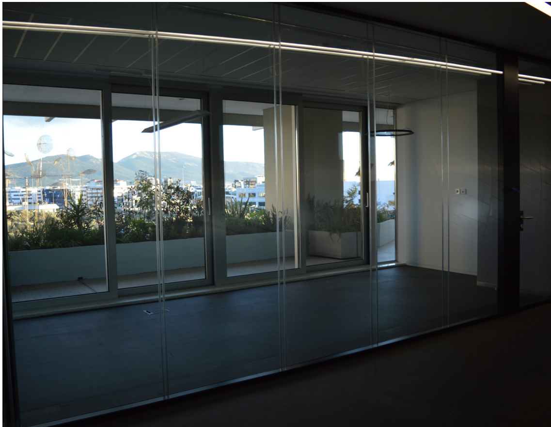
Εικόνα 5.5.1- Άποψη υαλοπετάσματος ΒΔ1 - γραφείο ΒΔ1- από το διάδρομο Δ.
