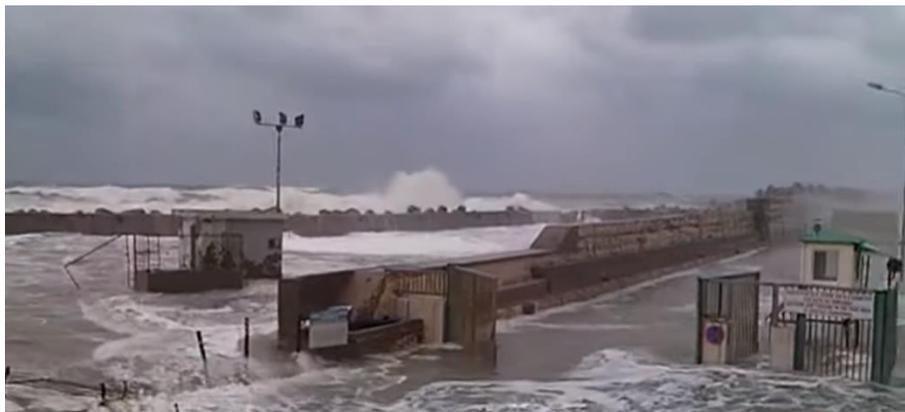
**Σχήμα 6.11** Πρόσφατη πλημμύρα στο λιμένα του Ρεθύμνου το 2015. Στο βάθος διακρίνεται η υπερπήδηση της κατασκευής λόγω των υψηλών κυματισμών.
