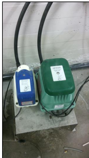
Σχήμα 4.17: Αεροσυμπιεστές (αριστερά χονδρής φυσαλίδας και δεξιά λεπτής φυσαλίδας)
