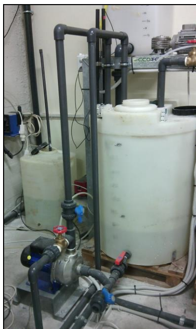
Σχήμα 4.8: Ανοξική δεξαμενή 2ης γραμμής επεξεργασίας πιλοτικού MBR
