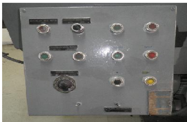
Σχήμα 8-2: Πίνακας ελέγχου του εκβολέα
