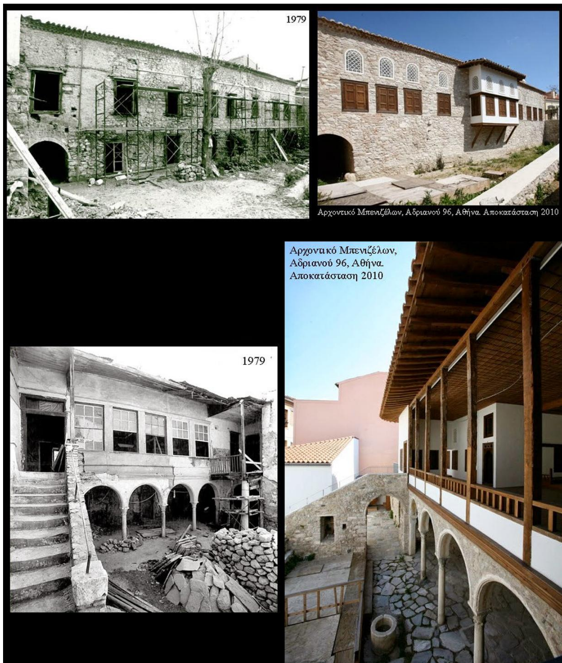
Εικόνα 4: Φωτογραφίες του Αρχοντικού Μπενιζέλων πριν και μετά τις εργασίες αποκατάστασης (Τριανταφύλλου, Γ., 2015)
