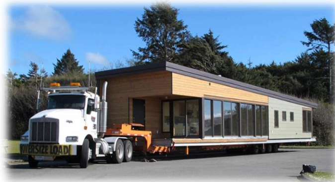
Σχήμα 2.3: Ειδική μεταφορά ολόκληρης κατασκευής
