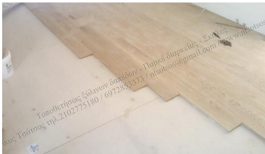
Σχήμα 6.2: Τυπική δομή συγκολλητού ξύλινου δαπέδου επί φύλλων κόντρα πλακέ.
