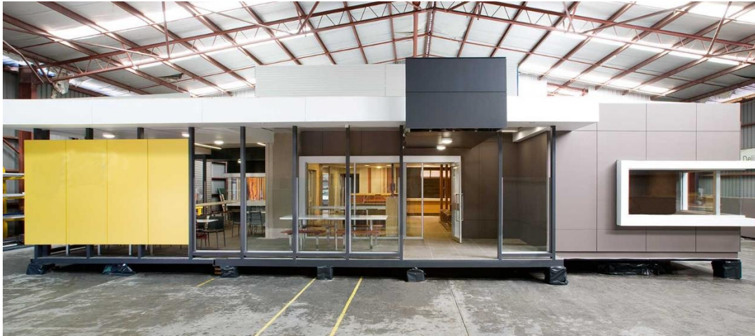
Σχήμα 2.2: Διαμόρφωση κτιρίου εξολοκλήρου στο εργοστάσιο
