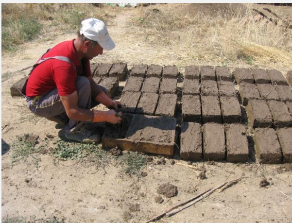
Εικόνα 12_Αρχείο Α. Γεωργαντά - 2010. Κατασκευή πλινθόκτιστων κτισμάτων στον Μηλιώνα Πρεσπών
